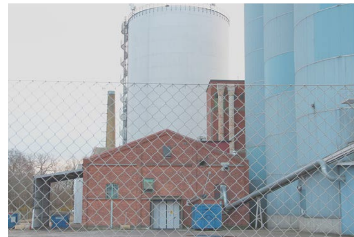
Figur 8: Ett gammalt magasin har fått sällskap av enorma silos. Stadsbyggnad handlar allt mer om utveckling och transformation av redan bebyggda miljöer.
