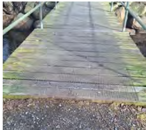
Bro över vatten med fyrkantsnät
