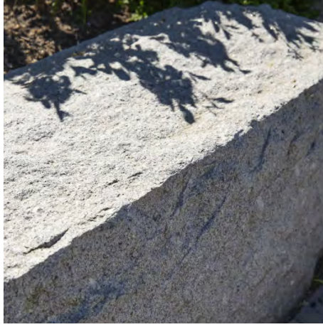
Blockstensmur som kanstöd runt planteringar längs Brynhilds promenad.
