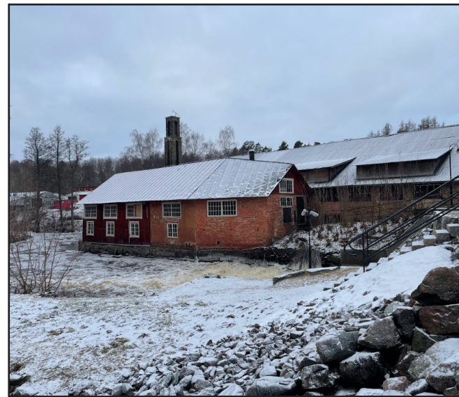
Figur 8. Fallet nedan dammen och några av brukets karaktäristiska byggnader
