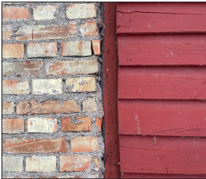
Figur 7. Fasadmaterial i bruket
