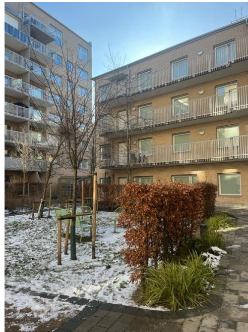
Figur 19: Lägenheter i loftgångsstil samt södra halvan av gräsmattan.
