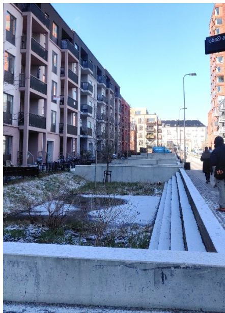
Figur 5. Nedsänkta ytor i Köpenhamn där det finns utrymme för rekreation som kontrollerat kan svämma över vid höga vattenflöden (Pramler 2023).
