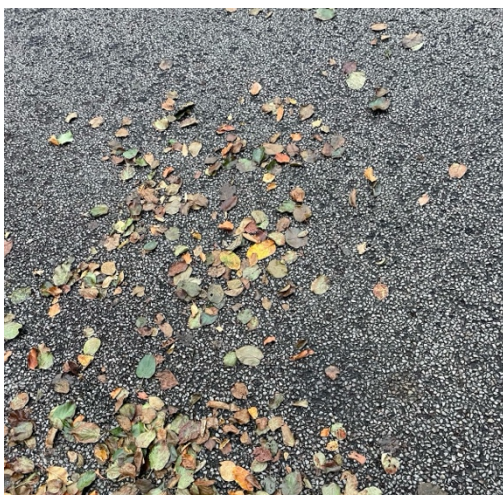
Figur 23. Löv från intilliggande träd tillför organiskt material som kan bidra till igentäppning på Pysslinggatan i Malmö (Foto: Asrar Emad).
