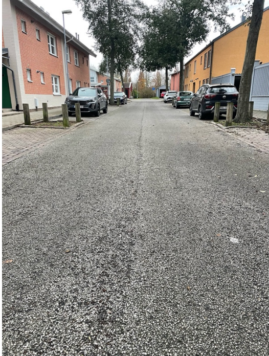
Figur 24. Pysslinggatan i Malmö som haft hyfsat optimala förhållanden för en lång livslängd av permeabel asfalt (Foto: Asrar Emad).
