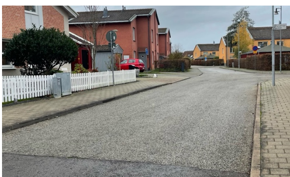
Figur 17. Blöt permeabel asfaltsyta på Pysslinggatan. (Foto: Asrar Emad).
