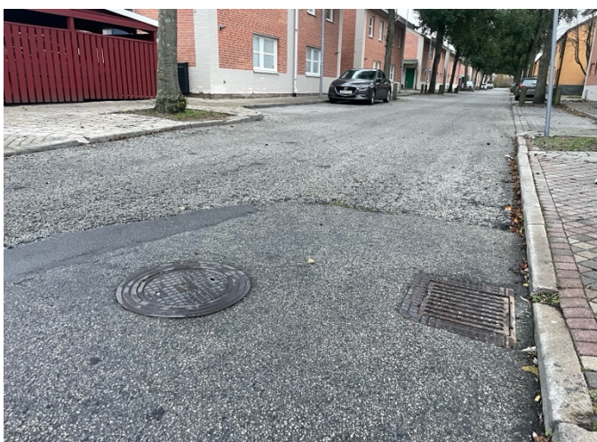
Figur 22. Kompletterande dagvattenbrunn på permeabel asfalt på Pysslinggatan, Malmö (Foto: Asrar Emad).
