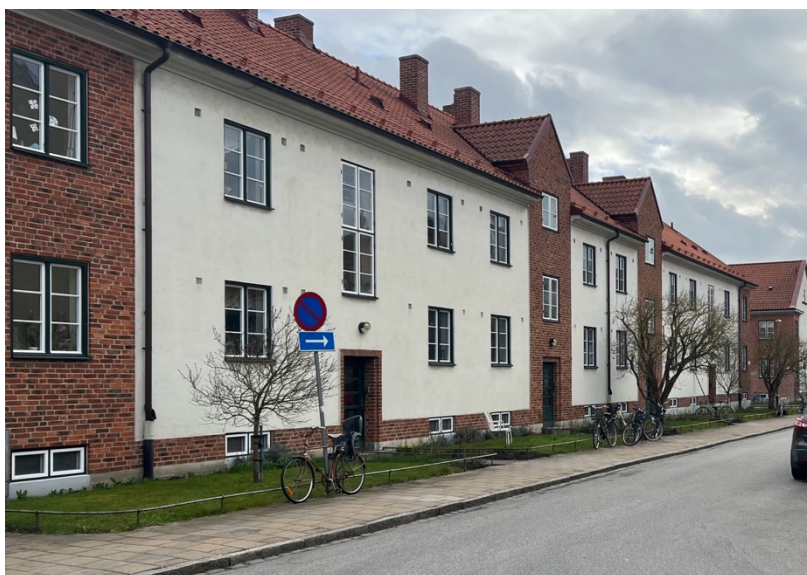
Figur 9. Den nutida gatubilden vid Mäster Palmsgatan 5 i Västra Sorgenfri. Fotograf: Jacob Wallin. Datum: 2025 – 03 – 12.
