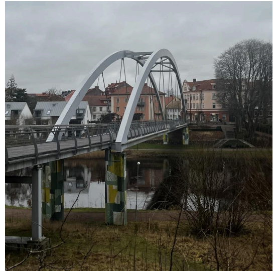
Bild: Tullportsbron som kopplar samman sjukhusområdet med stadens centrum.
