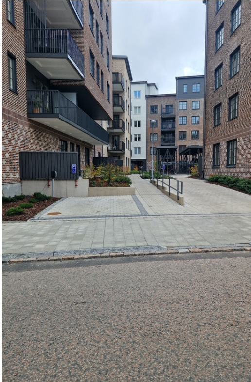
Figur 48. Sydöstra öppningen till gården med ramp, planteringar och parkering för rörelsehindrade
