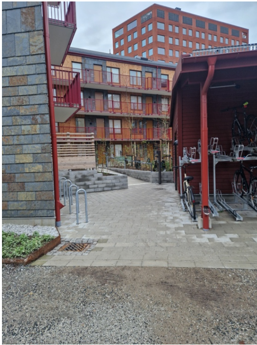
Figur 9. Ena av öppningarna mot norr med nivåskillnader och ramp
