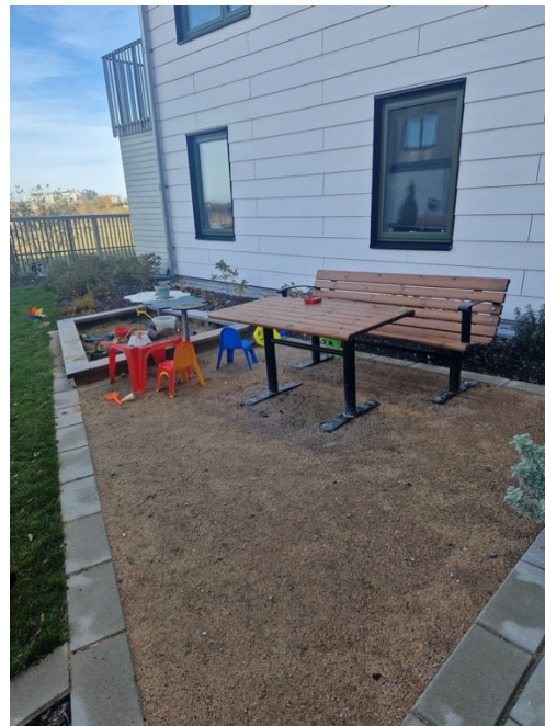
Figur 46. Lekyta med sandlåda och sittplats, nära inpå fasad och fönster
