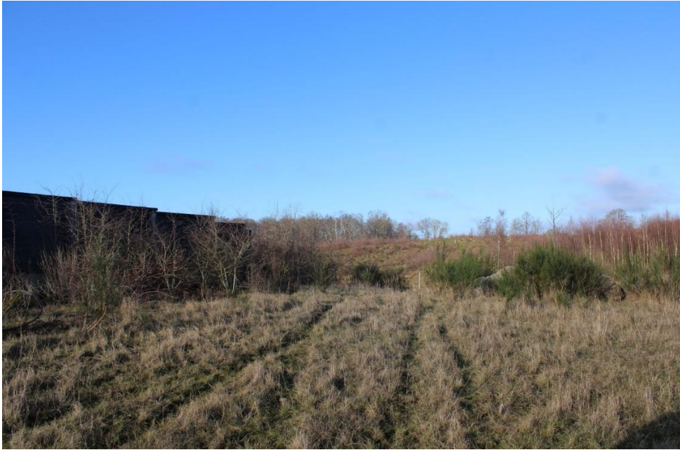
Figur 11. Djurspår på Ekodukt Lemmeströtorp, foto taget mot norr (Eliasson 2025).
