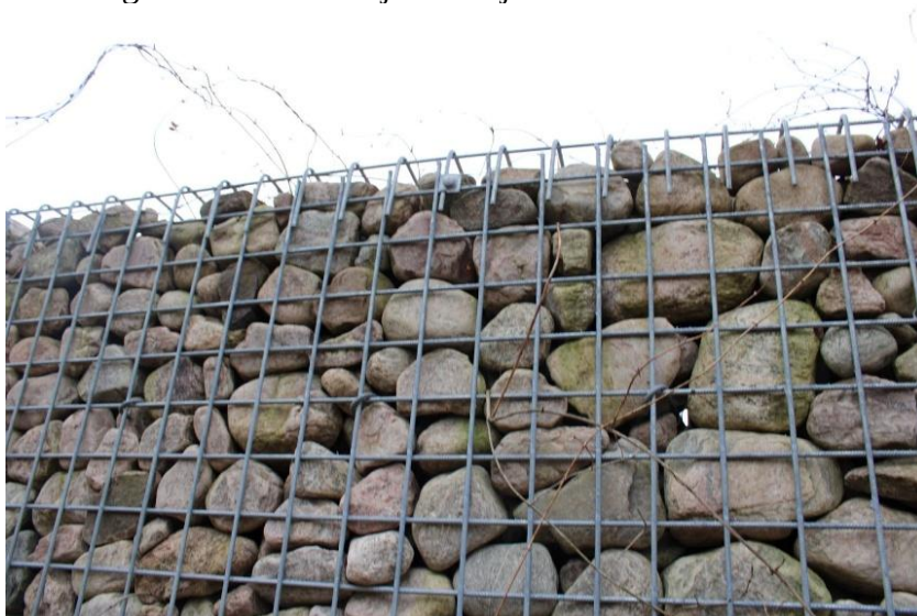
Figur 19. Gabionmur vid ekodukt Hallandsåsen (Eliasson 2025).
