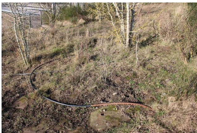
Figur 10. Vattenslang på Ekodukt Lemmeströtorp, foto taget mot öst (Eliasson 2025).
