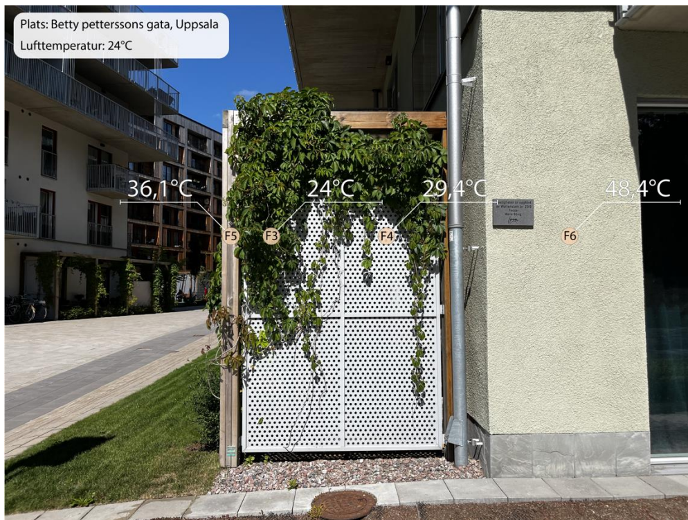
Figur 6: På bilden syns olika material och dess uppmätta temperaturer. Punkt F3 är mot grönska, punkt F4 mot metall, punkt F5 mot trä och punkt F6 mot fasad i betong.
