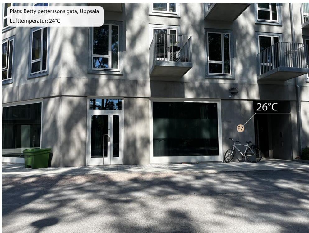
Figur 7: Bilden visar resultatet från temperaturmätningen av mätpunkten F7. Här syns en större, mer kontinuerlig skugga som skuggar den polerade betongfasaden.
