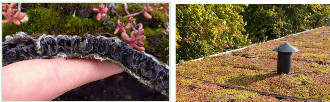
Figur 2. Studerade sedumtak, M9 och M17, som illustrerar substratdjup och taklutning. Foto: Ronja Zellmer, Green Roof Aging Project (2020).
