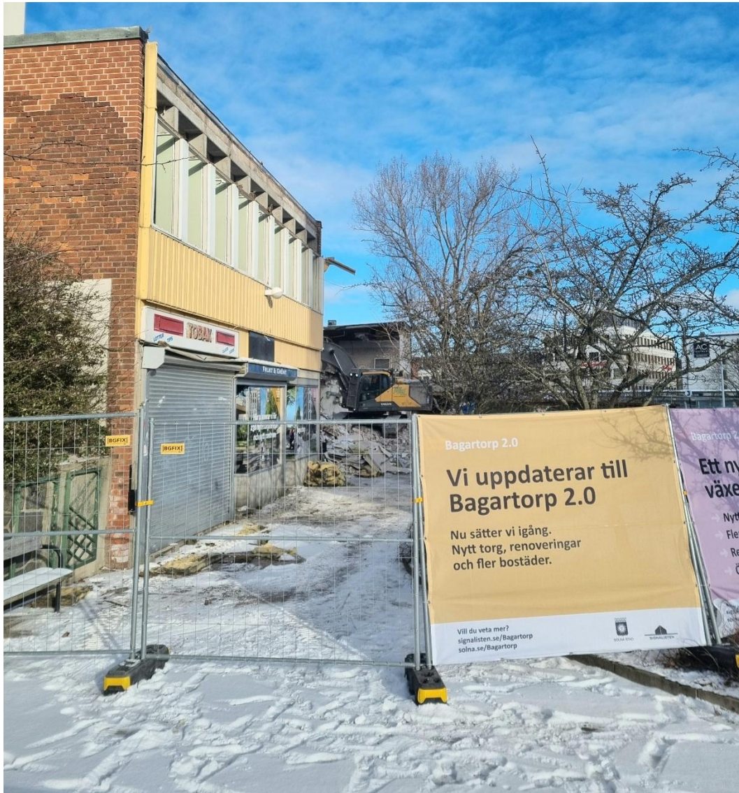
Figur 17. Det är viktigt att byggplatsen är organiserad på ett sätt så kvarteren fungerar och är trygga att vistas i även under byggtiden, eftersom byggskedet ofta ger upphov till brott och otrygghet (Uittenbogaard 2020) (eget foto).
