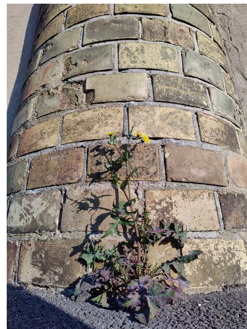
Figur 13: Tegelpelare på Torkladan idag. Byggt av Kockums tegel. Fotografier Linn Klaar Stenberg.
