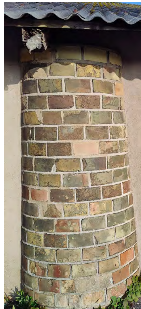
Figur 13: Tegelpelare på Torkladan idag. Byggt av Kockums tegel. Fotografier Linn Klaar Stenberg.
