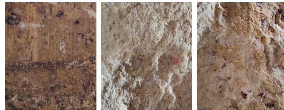
Figur 10: Det gula Lomma teglet, 2024. Detaljer från tegelpelarna från Torkladan. Fotografier Linn Klaar Stenberg.
