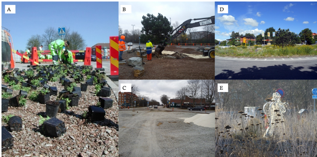
Figur 8. Bilder A-C visar byggnation av Trollebergssrondellen. (Lunds kommun arkiv, 2011). Bilder D-E visar färdig rondell sommartid och vintertid. (Mats Andersson Espling, 2014)
