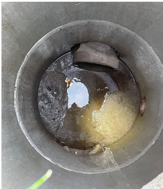
Figur 12. Brunn som idag har ett visst vattenflöde, men pluggas igen för gynnandet av de öppna gröna lösningarna.
