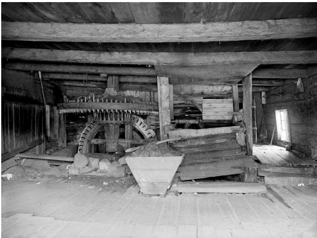
Figur 1. Bild på kugghjul med kuggar i oxelvirke. Bildtexten i Hultgren & Hamilton (1975) lyder ”I Ösjöfors pappersbruk från 1777 är allt maskineri av trä. Det stora hjulets kuggar är tillverkade av oxel – segast av träslag.”. Foto: August Christian Hultgren, Östergötlands museums samlingar.
