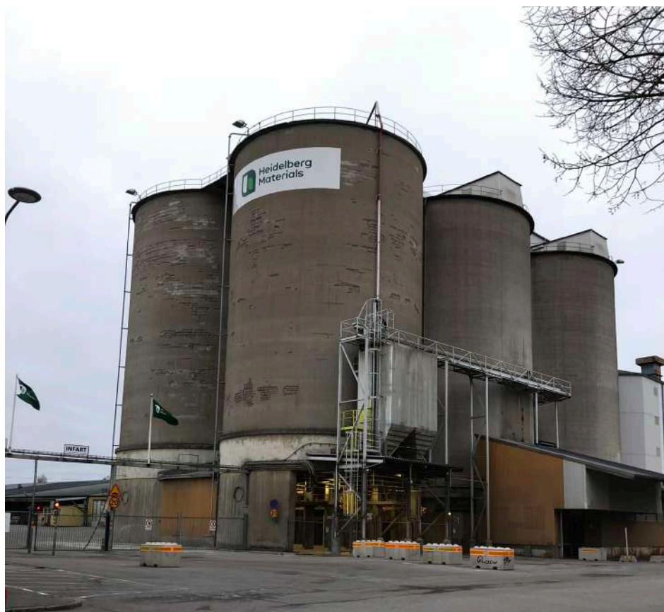
Figur 8: Cementas siloanläggning är den högsta byggnaden på Lövholmen idag.
