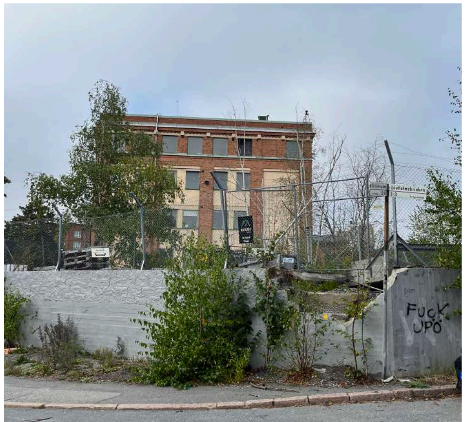
Figur 10: Träd, sly och örter har klamrat sig fast i sprickor i asfalten och vid de minst använda ytorna.
