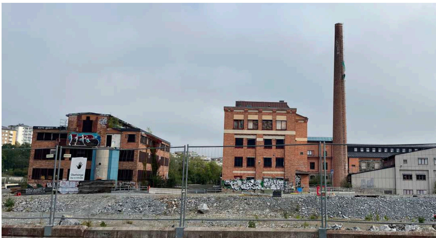
Figur 2: Sett från Lövholmsvägen syns de påbörjade rivningarna av industribyggnader, en del av förberedelserna för Lövholmens omvandling till en ny stadsdel.
