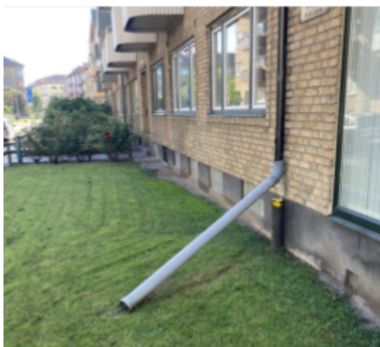
Figur 7 (Vänster) Lokalt omhändertagande av dagvatten i form av stuprör som leder dagvatten från tak direkt till gräsmatta. Malmö 2023
