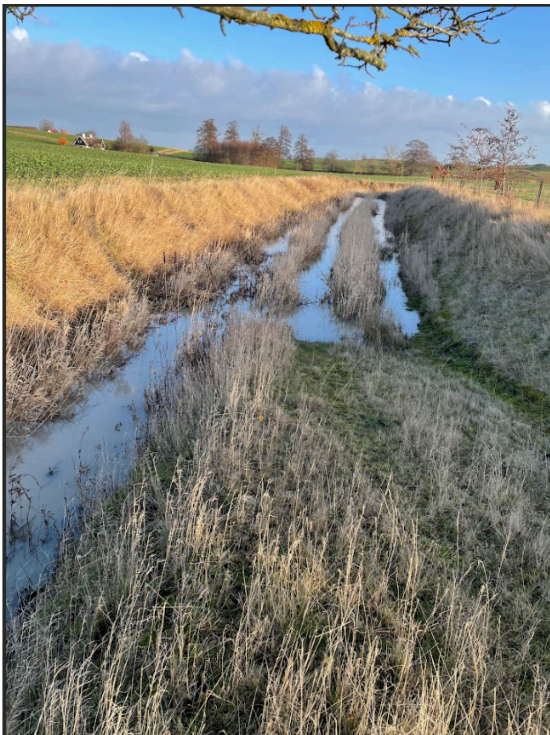
Figur 15. Övergång mellan konventionellt dike till tvåstegsdike. Bild tagen efter några dagar med mycket regn vilket har översvämmat både mittfåran och svämplanerna. Anderslöv 2024-12-20.
