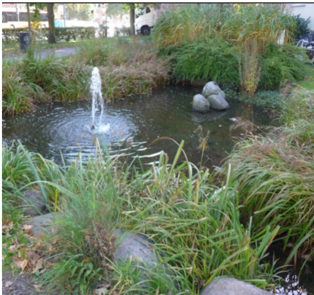
Figur 10. Exempel på samlad fördröjning - Dagvattendamm i Malmö, 2023
