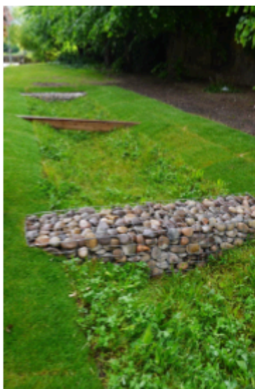
Figur 8 (Höger) Svackdike med kraftig vegetation (lågt mannings tal) och hinder i form av stenkista, detta hinder bromsar flödes hastigheten på dagvatten samtidigt som det kan fungera som en bro över diket. Exempel på trög avledning Bildkälla: Jonathan Malmberg, boverket. Författare innehar publiceringsrätt. Boverket (2019). Hämtad 2025-02-28
