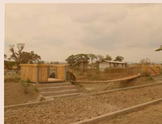
Figur 7. Vid Kao La Amani är lekmiljön nästan färdig, en hängbro i trä har byggts på schaktade kullar.
