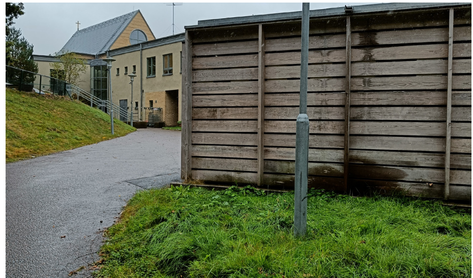
Figur 16. Skjul innan parkeringen norr om kyrkan längs med Gunnareds kyrkväg.
