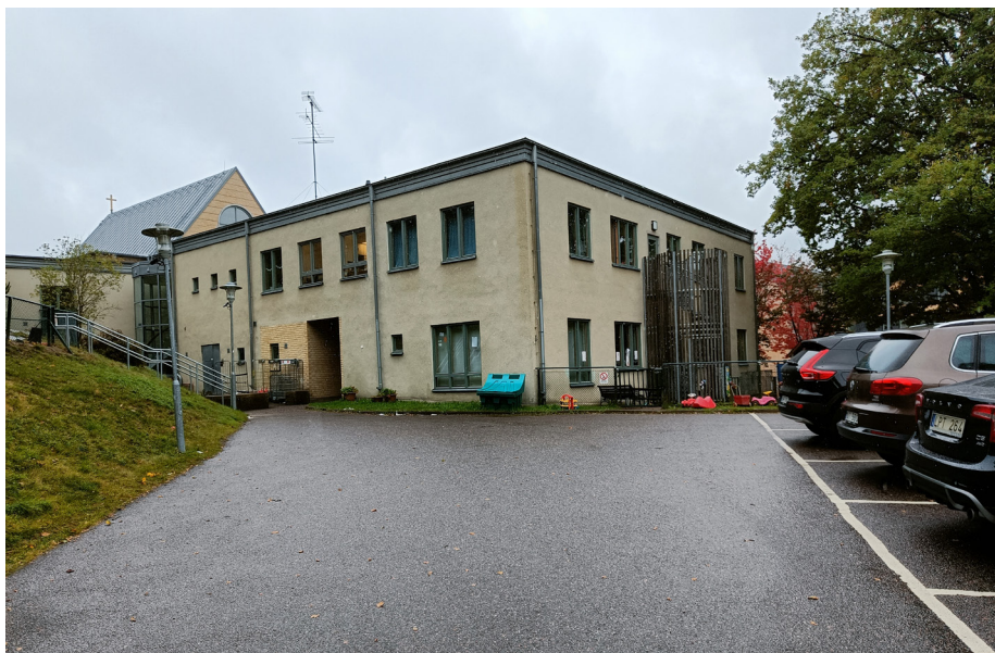
Figur 17. Kyrkobyggnadens bakre entré.
