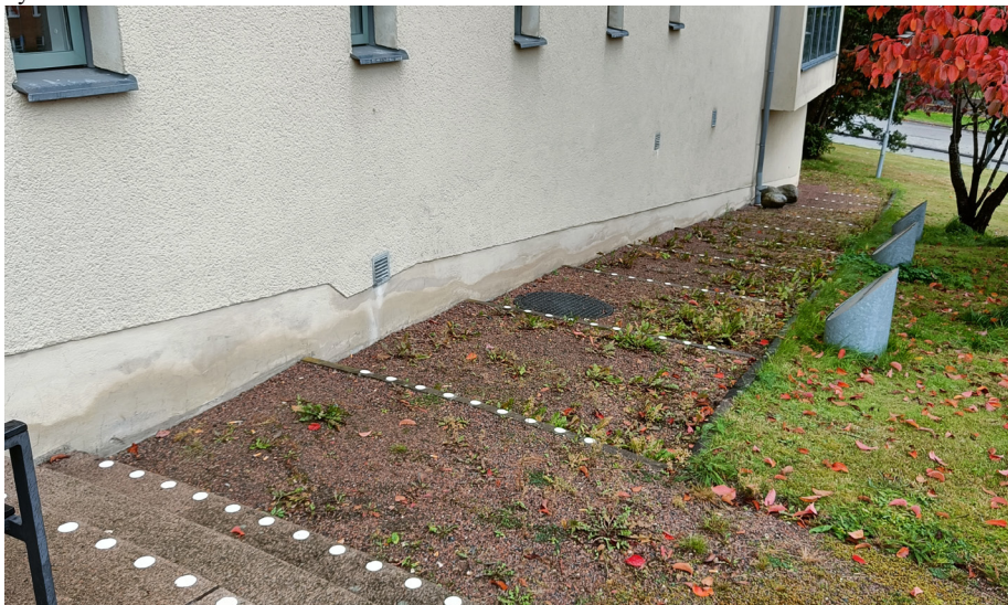
Figur 15. Trappan mot sydost som leder till en av byggnadens baksidor.
