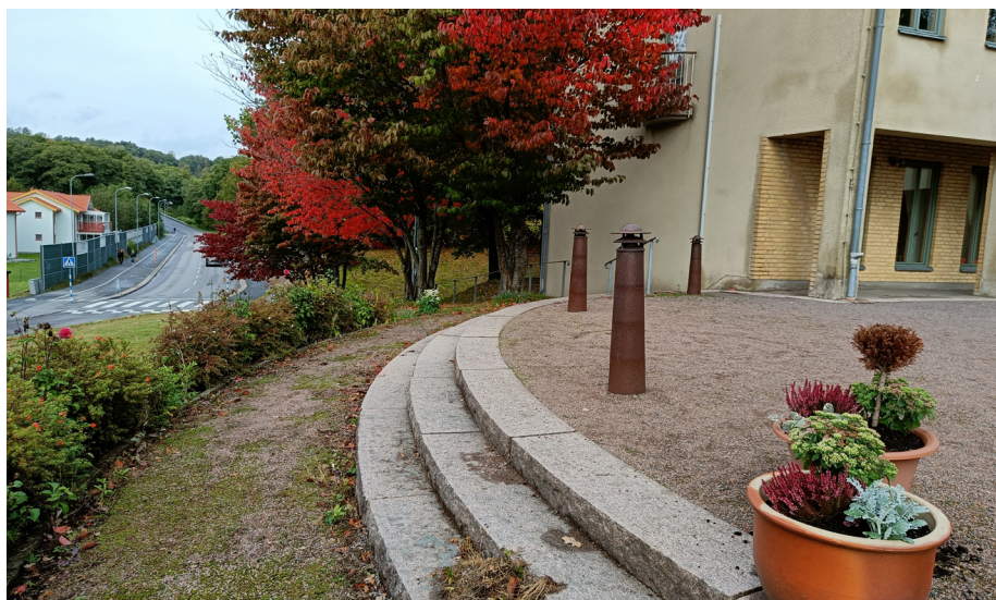
Figur 20. Rundad trappa som kantar innergården och vetter mot slänten.
