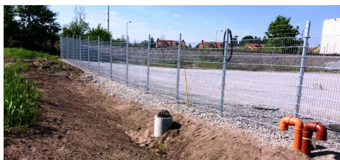
Bild 9, Goda dagvattenexempel i Stockholms län. Svackdike i Spånga intill parkeringsyta. Foto: VA-guidens anläggningswiki (u.å.). https://vaguiden.se/dagvatten/anlaggningswiki/svackdike/svackdike-i-spanga/
