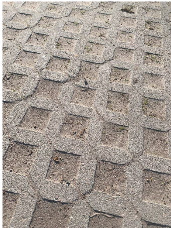
Bild 3, Igensatt rasteryta i centrala Kalmar. Foto: Wilma Stålhand (2024).
