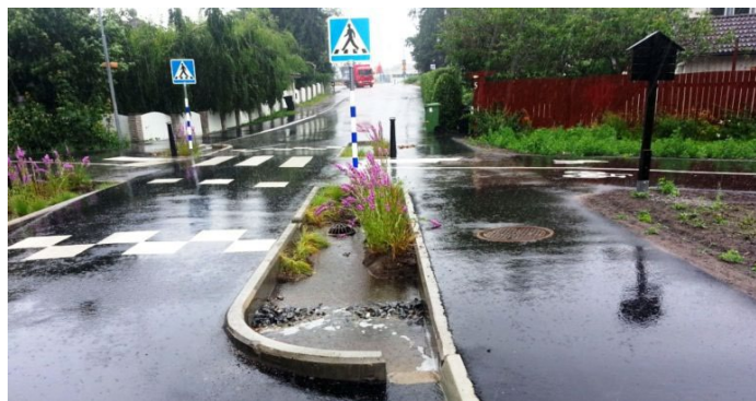
Bild 7, Goda dagvattenexempel i Stockholms län. Växtbäddar i Tyresö kommun, Öringevägen. Foto: VA-guidens anläggningswiki (u.å). https://vaguiden.se/dagvatten/anlaggningswiki/nedsankt-vaxtbadd/regnbadd-i-tyreso/
