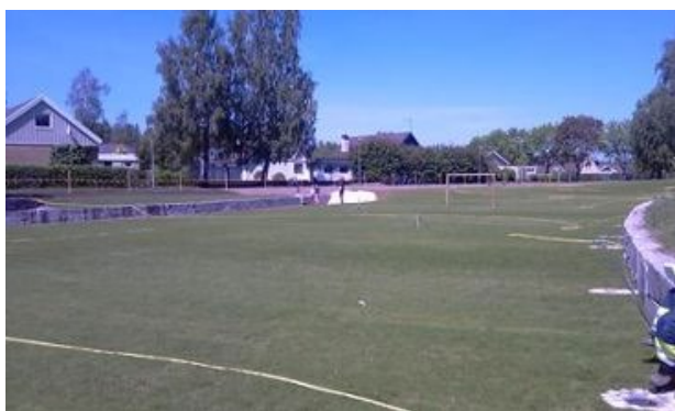
Bild 4, Översilningsyta i form av en fotbollsplan, Växjö. Foto: Malin Engström (2018). https://www.klimatanpassning.se/exempel/dagvattenlosningar-i-vaxjo-fordjupning-1.75382
