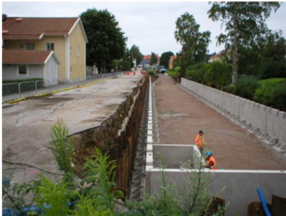
Bild 2, Byggnationen av avsättningsmagasinet, Växjö. Foto: Malin Engström (2018). https://www.klimatanpassning.se/exempel/dagvattenlosningar-i-vaxjo-fordjupning-1.75382
