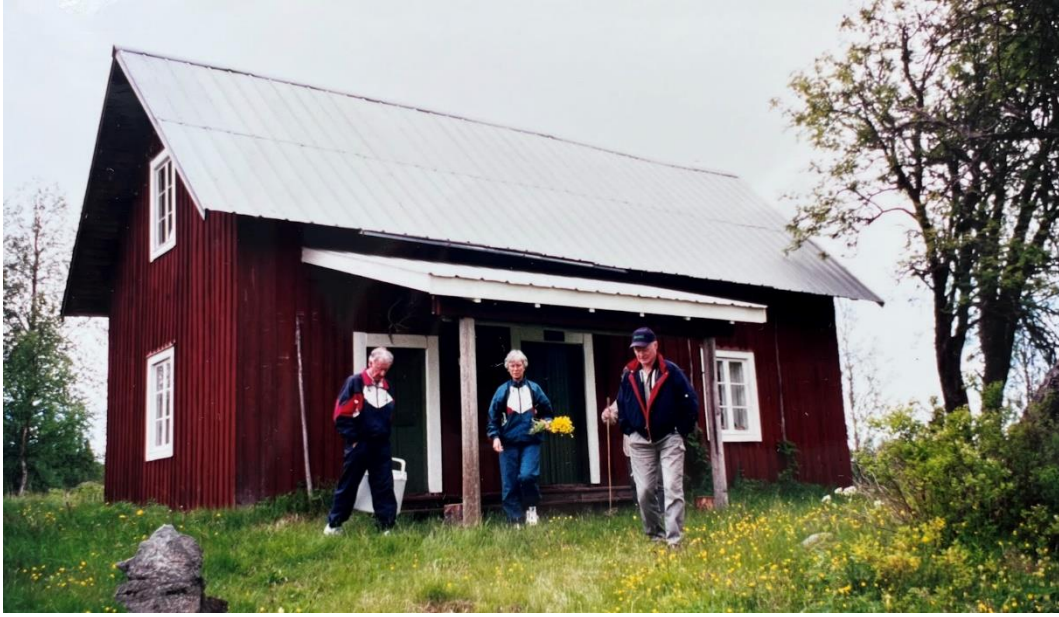
Figur 13. Bostugan på Kärnlundsbodarna efter renovering och takbyte (under 2000-talet). Foto: Gudrun Håkansson, privat
