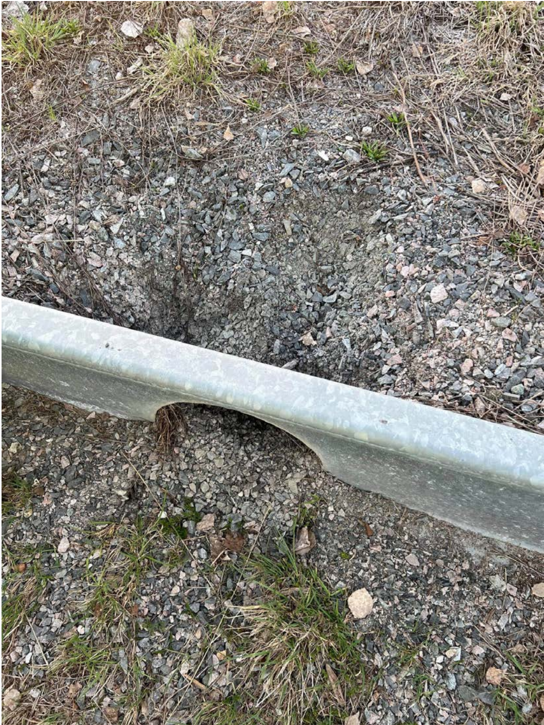
Figur 4. Konstruktionsbrist mellan ledarm och trumma.
