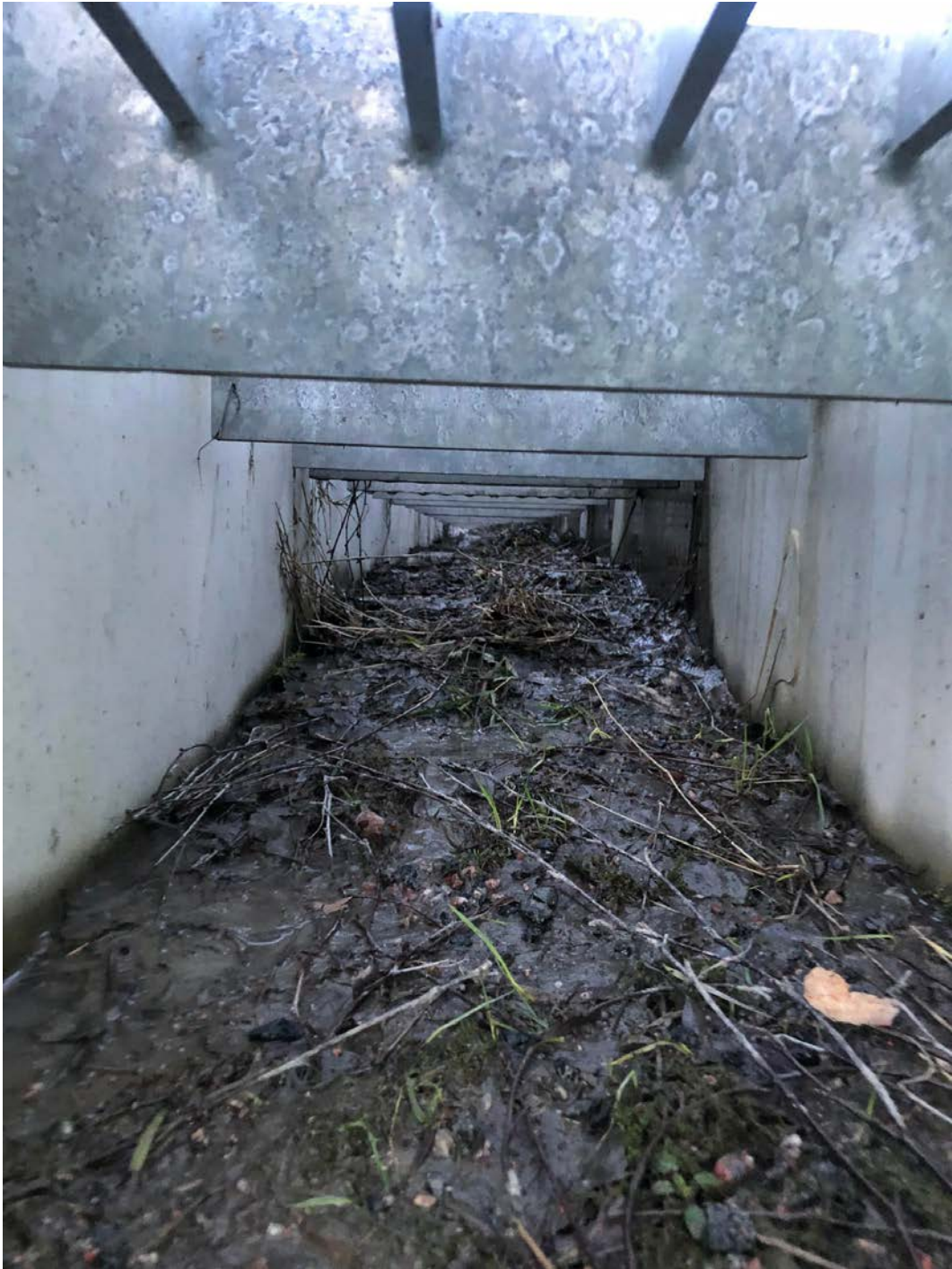
Figur 6. Under färysten med brist orsakad av jord, grus och vegetation.
