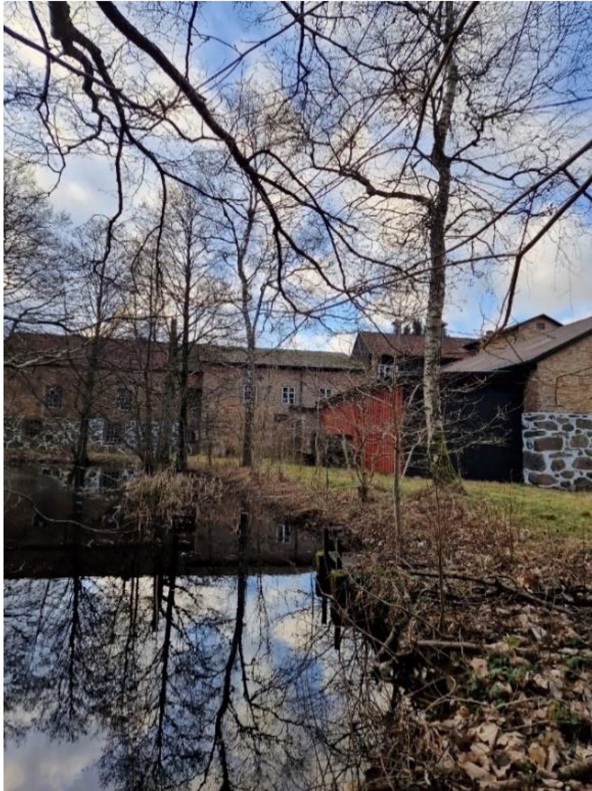
Figur 42. Dammens utlopp i nedre mitten av bilden markeras av en eroderad järnstruktur, överväxt av gräs, mossa och sly. Foto: Författaren
