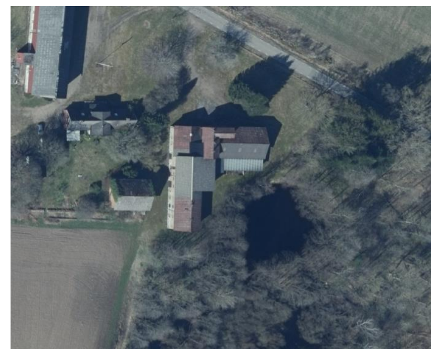
Figur 14. Den tidigare använda ytan norr om byggnaden är idag utjämnad och igenväxt. Dammen och kärret är omgärdade av stora träd, och det enda spåret från tidigare verksamhet som syns på bilden är spåren av vägen som leder in från asfaltsvägen mot byggnaden. Ortofoto ©Lantmäteriet
