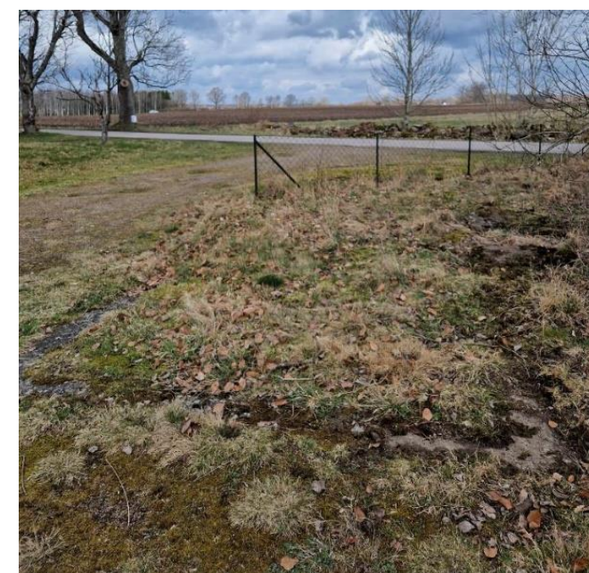
Figur 20. Betongfundamentet till vagnsvågen för vägning av potatis är idag överväxt och igenfyllt med sten och jordmassor. Foto: Författaren
