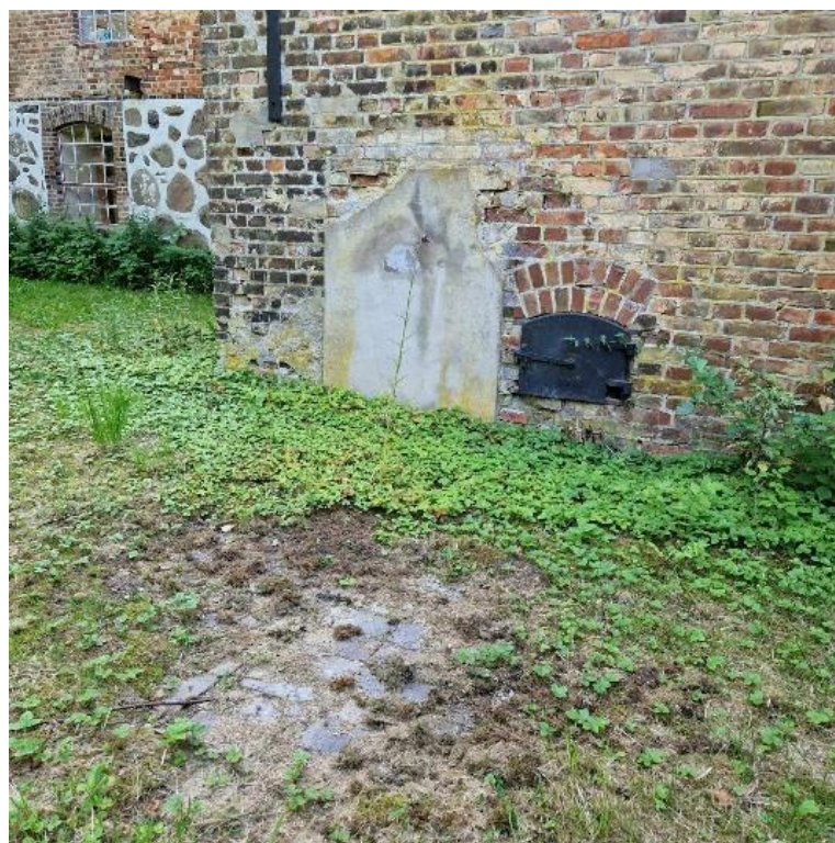
Figur 45. Där skorstenen tidigare stod finns spår av tegellagt golv överväxt av mossa och örter. Luckan i väggen har troligtvis använts till bränsle. Foto: Författaren
