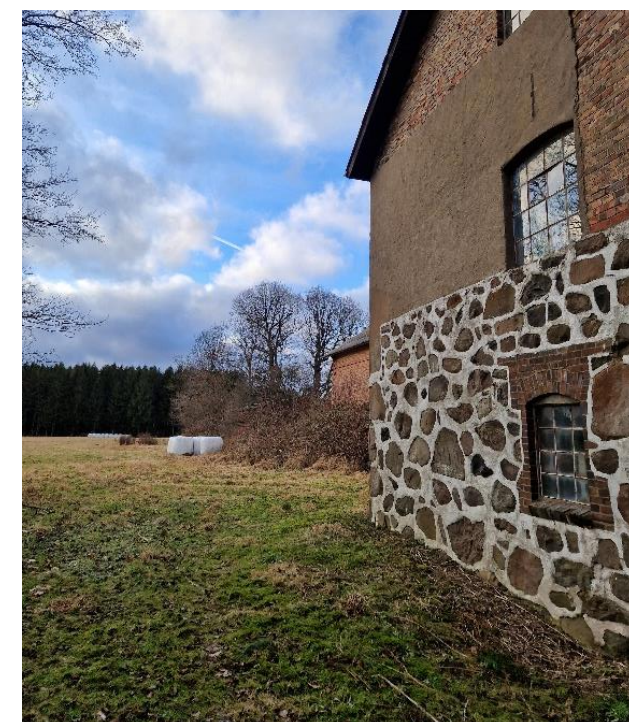
Figur 48. Vy mot väster visar bränneriets gavel och en fördjupning i marken intill väggen nedanför raden av fönster. Fördjupningen är troligtvis spår från ett utlopp från mäskrummet på insidan av byggnaden. Foto: Författaren
