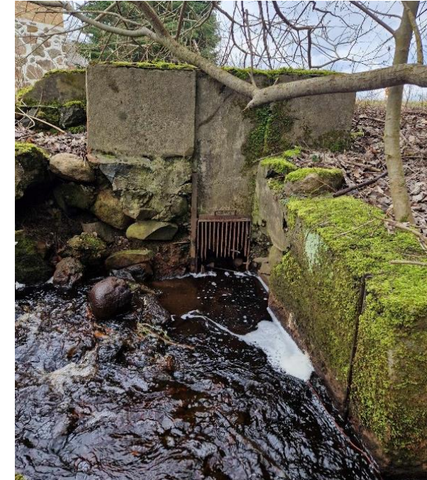
Figur 33. I jämnhöjd med vattenytan finns en öppning med galler för att släppa in vatten till insidan av pumpanordningen. I den förstärkande väggen av betong till höger i bilden syns en vertikal skåra som troligtvis varit del av ett fördämningssystem. Foto: Författaren
