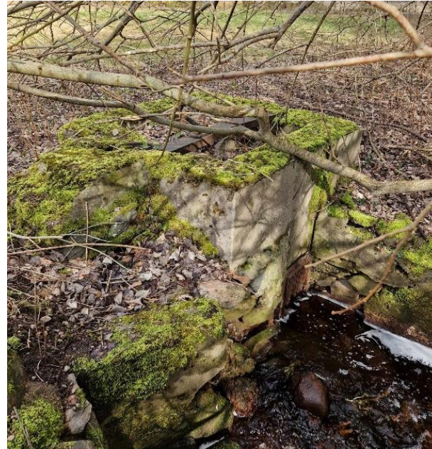
Figur 31. Vattnet som går från utloppet till dammen går förbi en pumpanordning som idag är nedgången, igenfylld och saknar detaljer. Foto: Författaren
