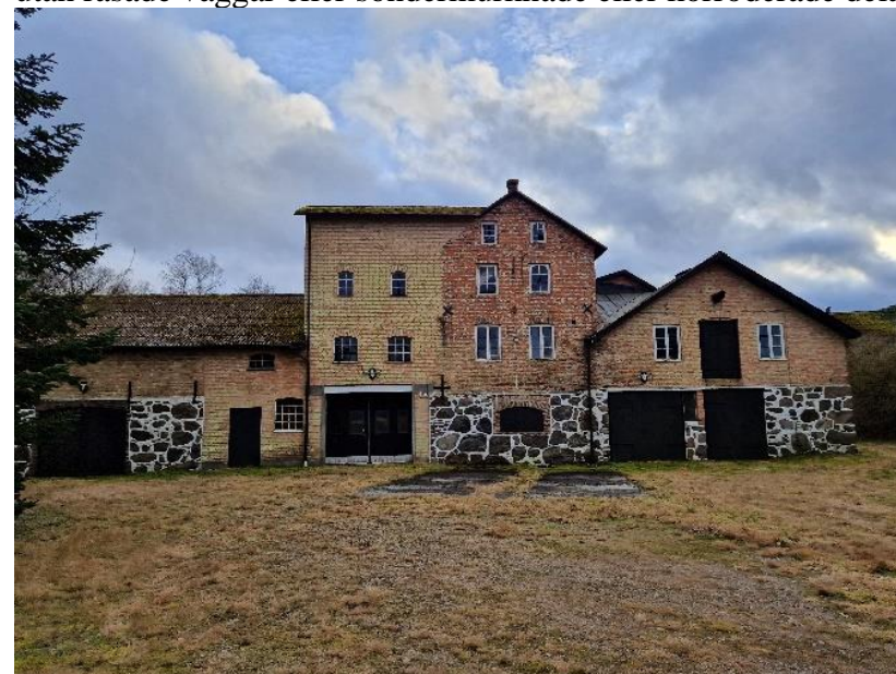
Figur 19. Bränneriet idag - väderpåverkad fasad, slitna fönster, mossbelagt tak och igenväxt markyta. Foto: Författaren
