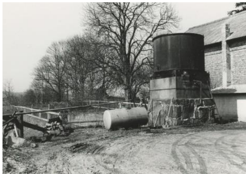
Figur 50. Drankbrunnen och drankpumpen låg förr vid bränneriets södra gavel intill grusvägen som gick runt byggnaden, här med bränneribyggnaden ur bild till höger. ©Lunds universitet
