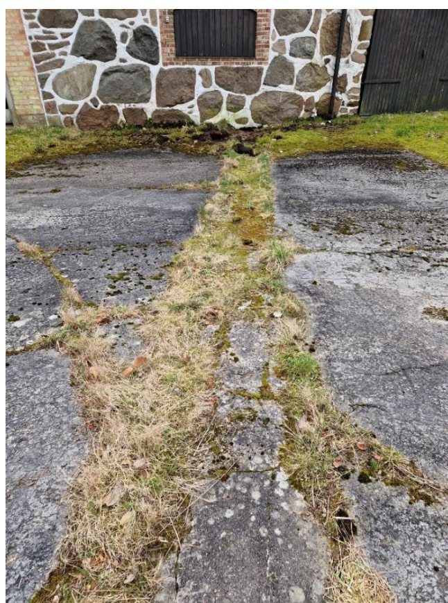
Figur 22. Betongplattan framför bränneribyggnaden fungerade som avlämningsplats för potatis. Idag är plattan sprucken. Vattenrännan har
