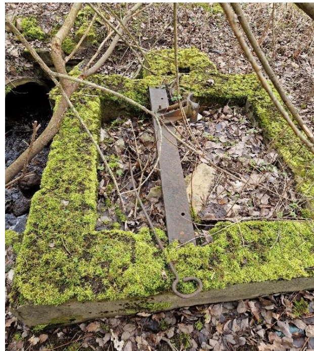
Figur 32. Järnbeslag på resterna av pumpen. Foto: Författaren
