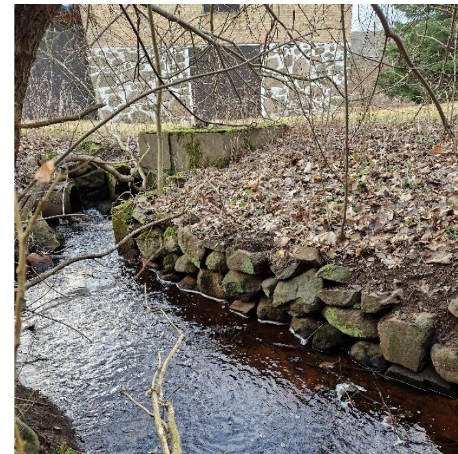
Figur 34. Dikets väggar förstärkta med sten står stadigt på en sida. Foto: Författaren
