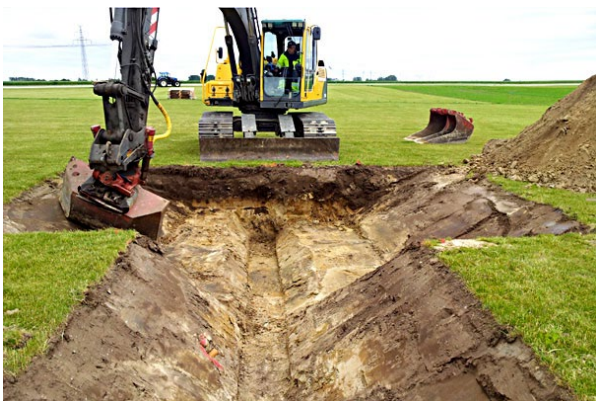
Figur 4. Demonstrationsgrävning av ett tvåstegsdike, som syns i bakgrunden, och ett vanligt dike, som syns i förgrunden. Foto: Zivko Rasic.
