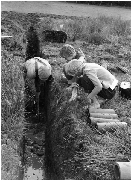
Figur 1. Täckdikning med tegelrör på 1950-talet i Gissle by, belägen i Härryda kommun, Västra Götalands län. Foto: Dagny Bengtsson.
