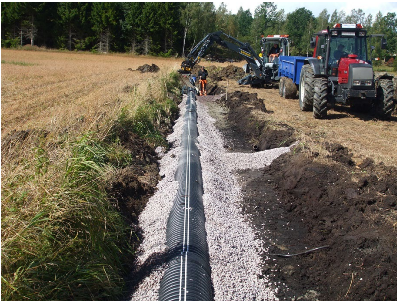
Figur 2. Kulvertering av ett dike i Ormestorp. Foto: Conradssons gräv i Gränna AB.
