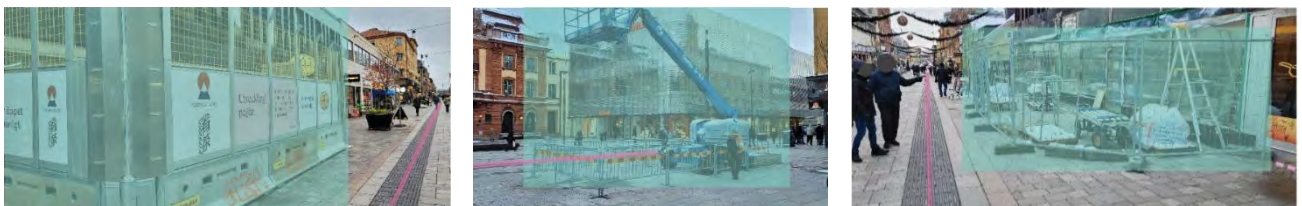
Figur 30: Bilder på de många byggarbeten som genomfördes i gaturummet. Längst till vänster och höger blockerar arbetet de naturliga ledstråken längs fasaderna, medan bilden i mitten endast står nära det konstgjorda ledstråket. Ingen av dessa byggarbeten stod på de konstgjorda ledstråken, men deras närhet till det gör att det inte är fritt på sidorna om ledstråket, och det kan uppstå en snubbelrisk.
