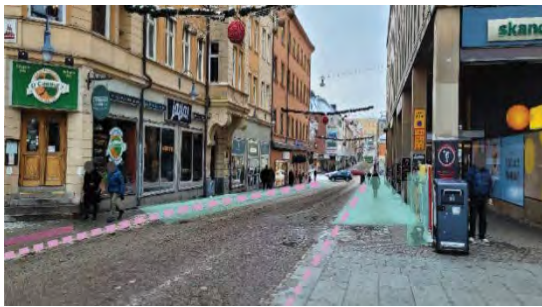
Figur 19: Bilden visar hur markvärmens håller torget fritt från snö, medan de delar av Drottninggatan som fortsätter efter torget inte har samma teknik, och därmed begränsas tillgängligheten.
