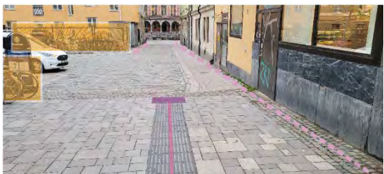
Figur 23: Det konstgjorda ledstråket slutar abrupt nästan mitt i gaturummet och kopplar inte på det naturliga ledstråket som löper parallellt längs med fasaden. Till vänster syns också cykelparkering som blockerar det naturliga ledstråket längs den fasaden.
