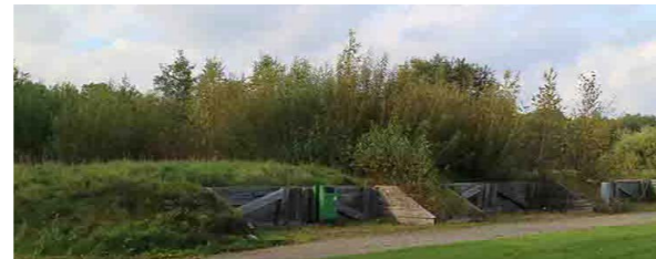
Fig. 55. (2023) Bilden visar vertikalfiltret som är överväxt med sly. Sidorna som är gjorda i trä har börjat förmultna och ge vika. Foto: Viktor Israelsson
