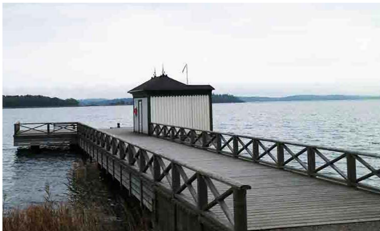
Fig. 23. (2023) Bilden visar tullgarnsviken med brygganläggningen och badhuset som uppfördes igen 2014 efter tidigare skador. Bryggans träkonstruktion är en inspirationskälla till gestaltningen. Foto: Viktor Israelsson
