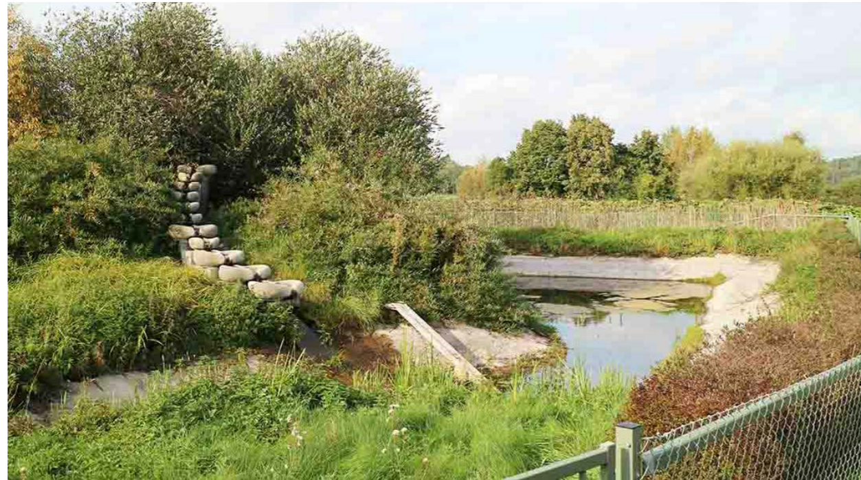
Fig. 43. (2023) En av reningsdammarna som har klätts med betong för att förhindra läckage av det tidigare avloppsvatten som pumpades in till dammen. En vattentrappa kommer ut ur vegetationen. Stängslet var en säkerhetsåtgärd för att hålla besökare på avstånd från avloppsvattnet. Foto: Viktor Israelsson
