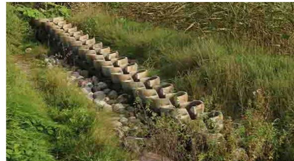
Fig. 53. (2023) Bilden visar vattentrappan vid damm 5 som inte var i bruk under besöket. Foto: Viktor Israelsson
