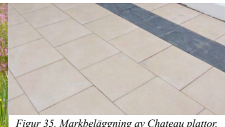
Figur 35. Markbeläggning av Chateau plattor. (Betong & Marmor AB 2021) (CC BY-NC-ND 2.0). Typexempel för markbeläggningen i figur 61.
