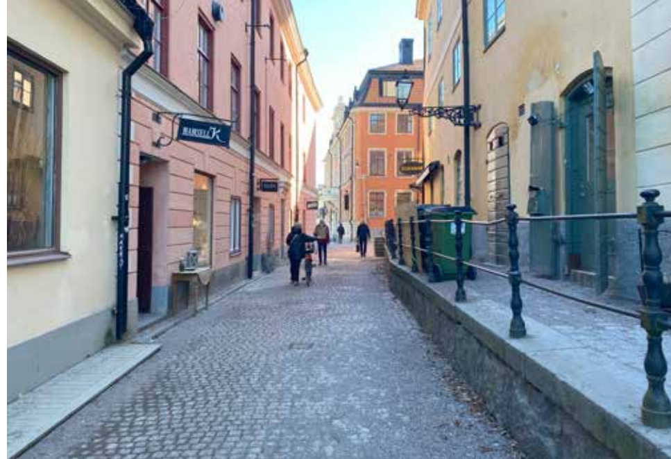
Figur 41: Valvgatan och St:Eriksgränd som ansluter vid Fyristorgs nordvästra hörn är belagd i smågatsten med en granitmur som terrass med storgatsten samt gjutjärnsdetaljer.
