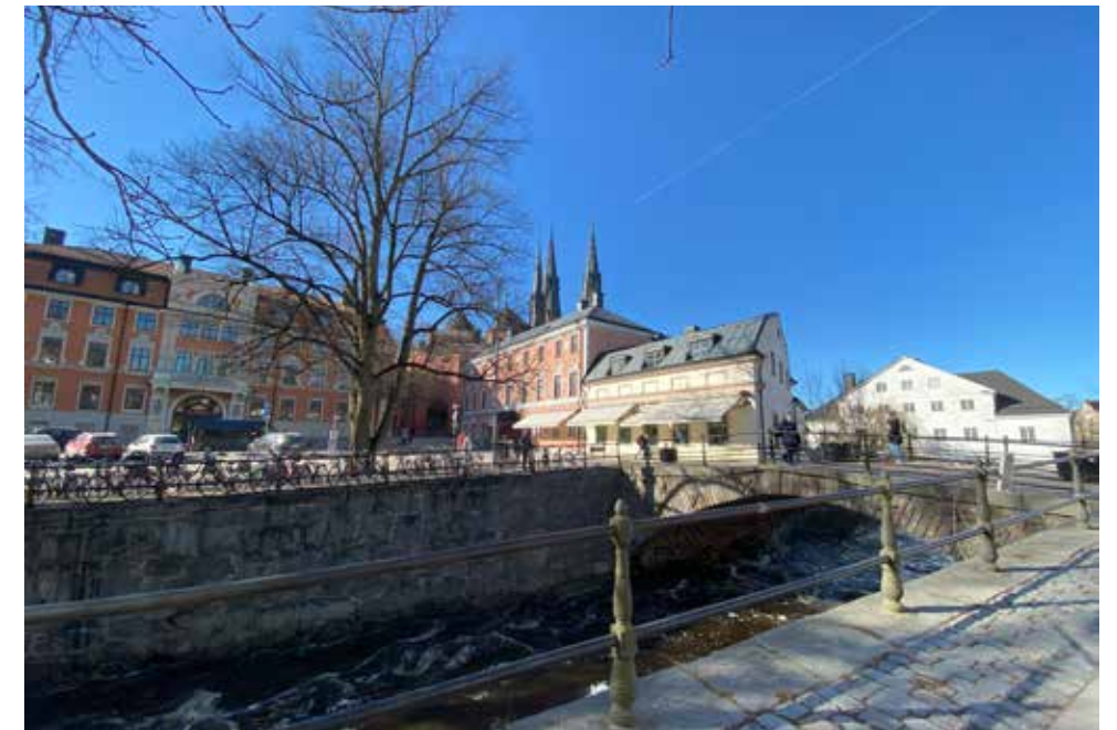
Figur 38: Domkyrkans torn reser sig över byggnaderna och gör sig sedda i stora delar av Årummet.
