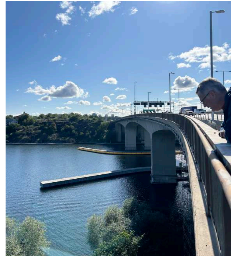
Fig 42. Sidbild på Gröndalsbron visar på att bron är högst på mitten och sluttar ner mot sidorna. Foto Richard Gustafsson
