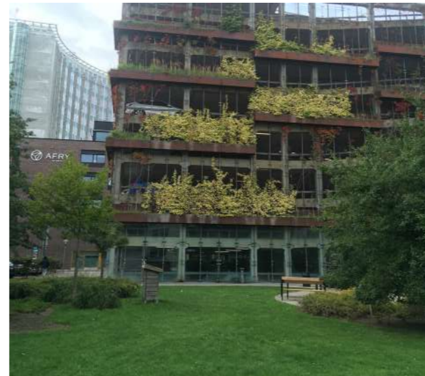
Fig 4. Plantering på fasaden av ett parkeringsgarage i Västra Hamnen, Malmö. Foto Camilla Gustafsson
