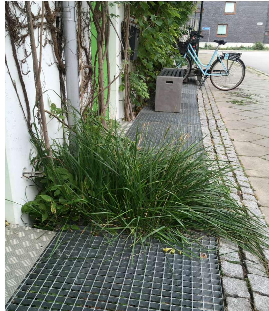
Fig 50. Foto på gallerdurk som använts som gångväg vid entéerna till huset. Det finns möjlighet för växter att växa under och upp igenom gallerdurken. Foto Camilla Gustafsson
