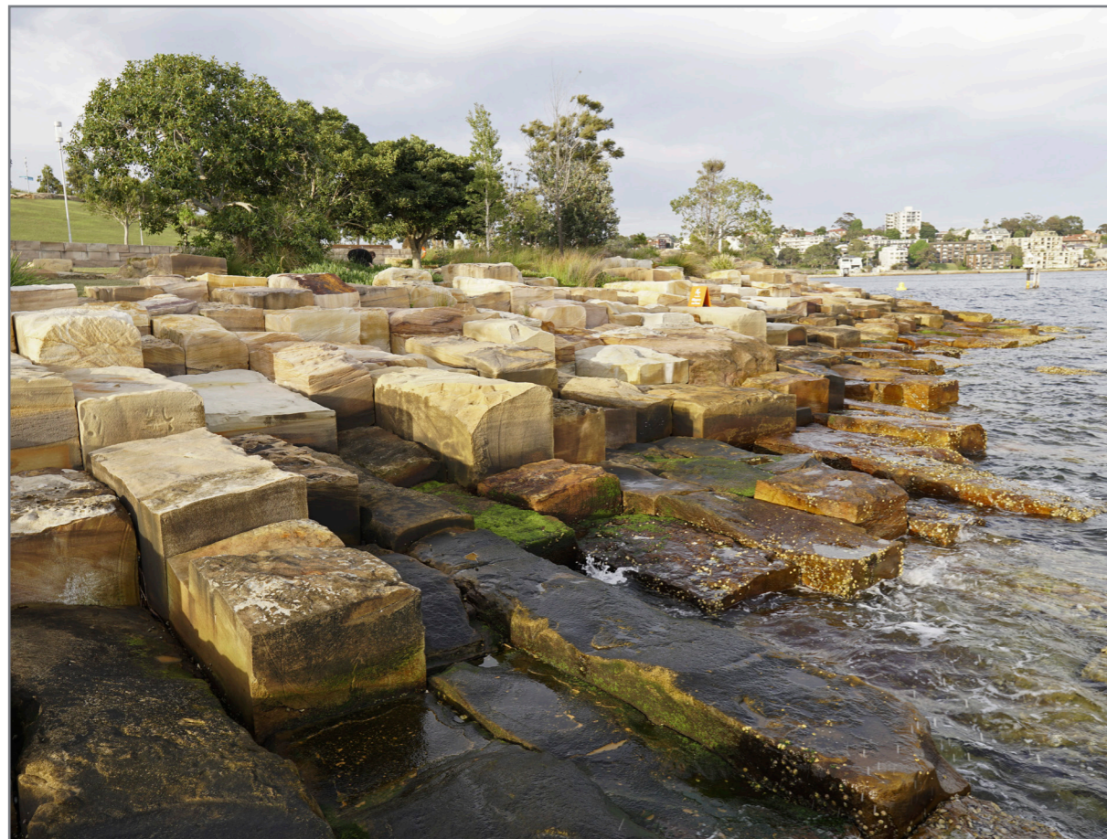
Figur 36 - Sluttande kustlinje med varierande nivåer i Sydney, Australien, efterliknar förhållanden i naturen. Foto: John Turnbull.
