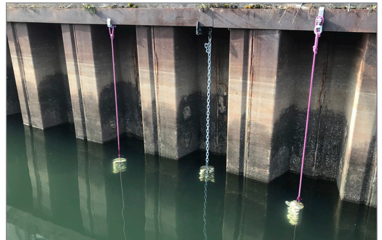
Figur 31 - Här skapas en bättre livsmiljö för marint liv med hjälp av tomma ostronskal som hänger ner från en spont i New York, USA. Foto: Newtown Creek Alliance.
