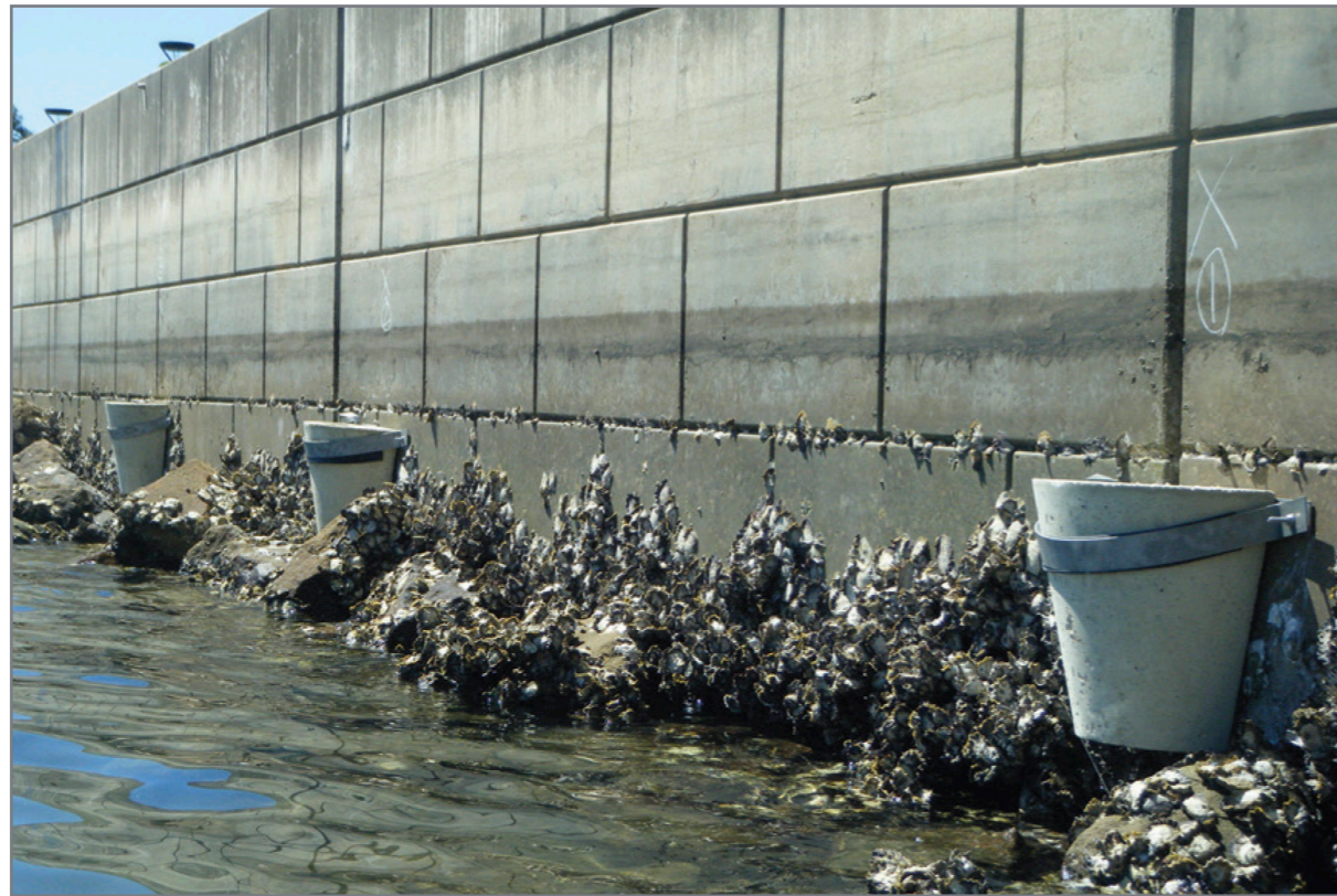
Figur 40 - Blomkrukor används som hällkar på kajvägg i Sydney hamn, Australien. Foto: NSW Department of Primary Industries.
