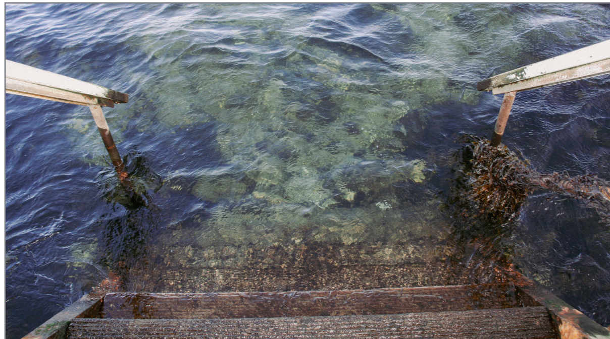
Figur 43 - Trappor och ramper ner från bryggan möjliggör människor att komma nära vattnet och det skapar goda fästytor för tång, alger och musslor att växa på.
