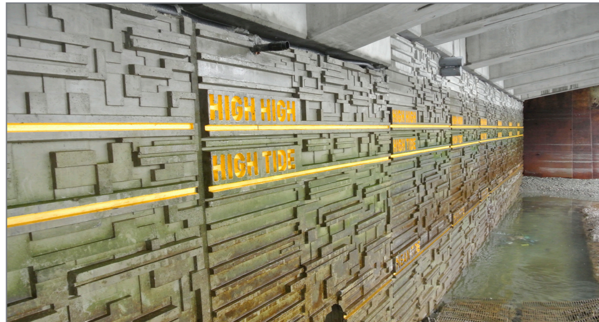
Figur 26 - I samband med ombyggnaden av en hamn i Seattle, USA, byggdes kajväggarna om för marint liv. Foto: The Seattle Department of Transportation.
