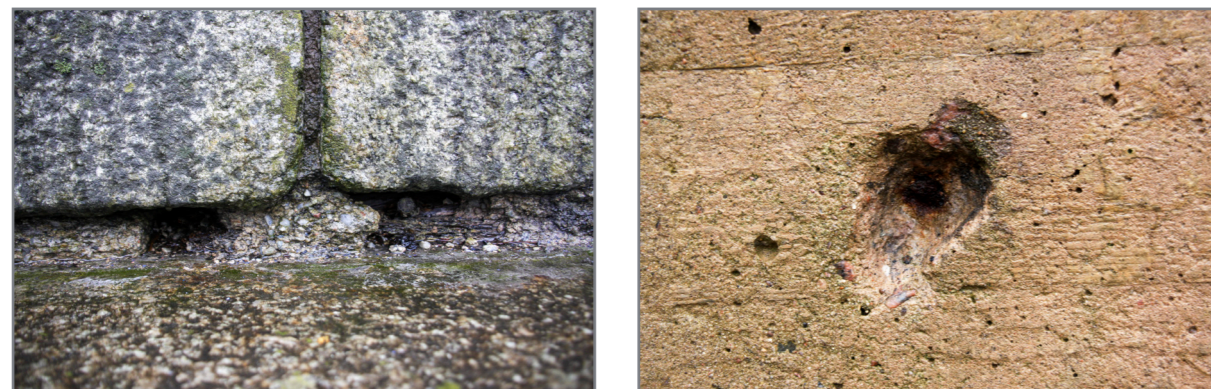
Figur 27 - Fogar mellan stenar som tas bort eller små hål i stenarna skapar utrymmen för djur.
