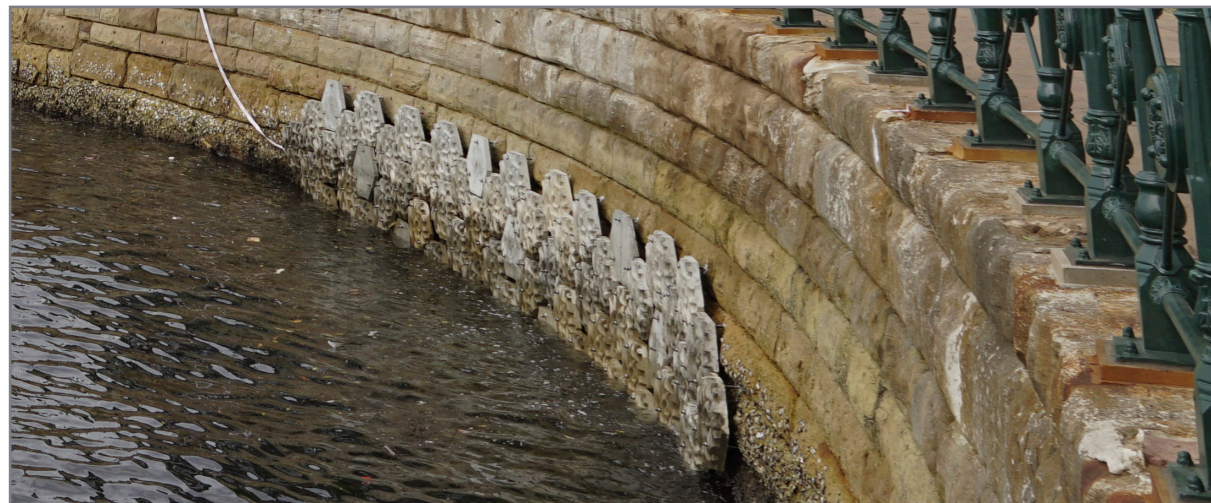
Figur 4 - Strukturplattor på en kajvägg i Sydney hamn, en så kallad "Living Seawall". Foto: John Turnbull.
