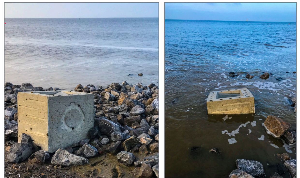
Figur 41 - Artificiella hällkar i Nederländerna, tillverkade av urgröpta betongkar. Foto: Reefsystems.
