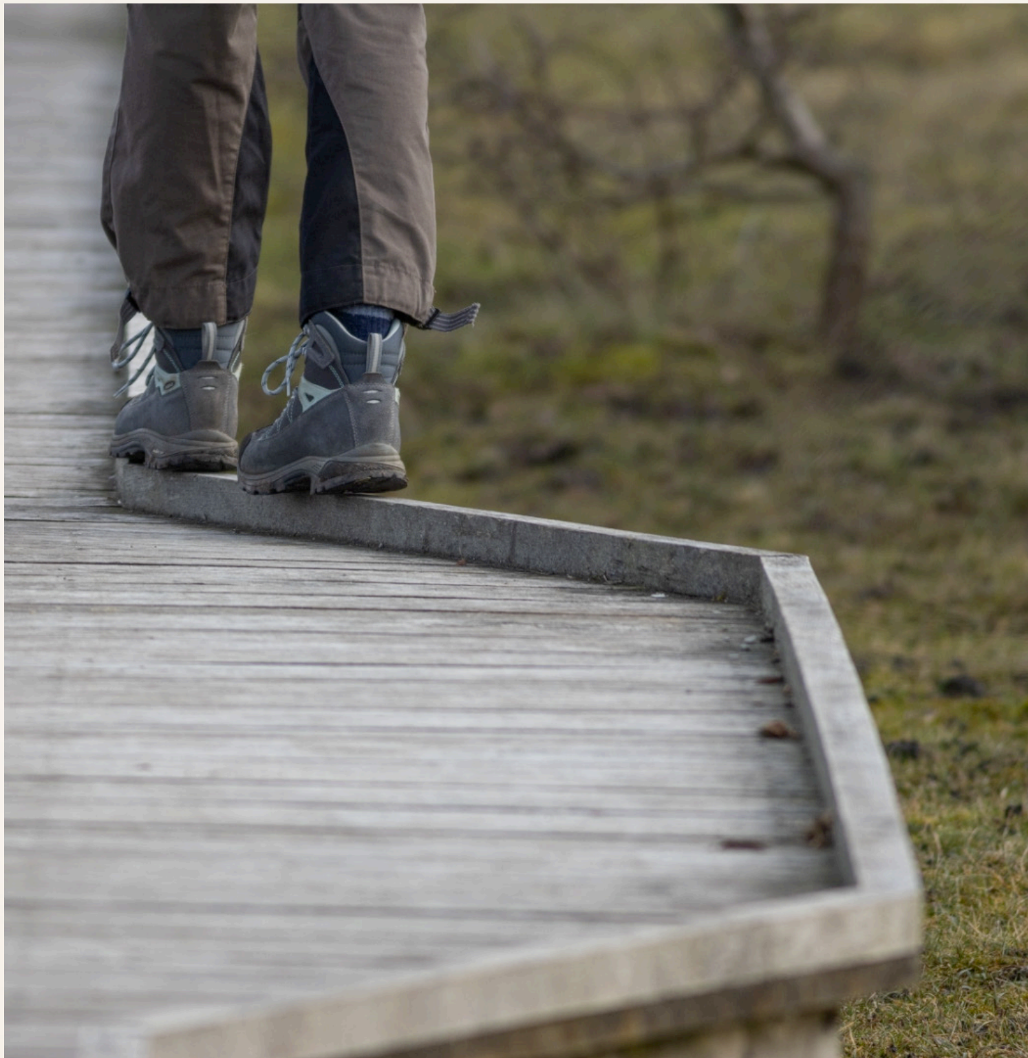
Fig 14. Stabila och något upphöjda spänger indikerar med tydlighet var människor kan och bör gå. Det blir naturligt för människor att följa spången för att inte bli blöta och leriga. Detta ger även djurlivet i våtmarken ett förutsägbart förhållningssätt till rekreatörerna. Klagshamn, Malmö.
