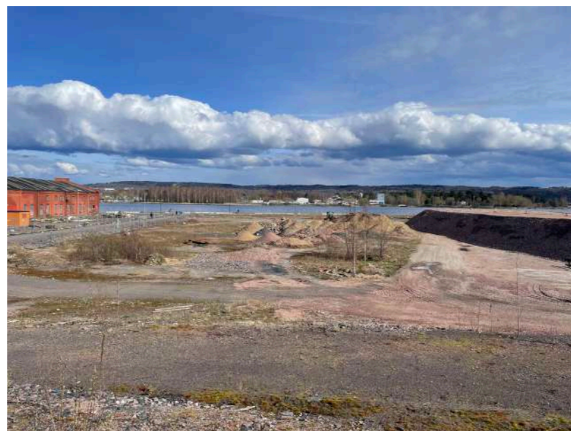
Figur 12/ Fotografi som togs under ett soligt platsbesök med utblick över den pågående byggarbetsplatsen.
