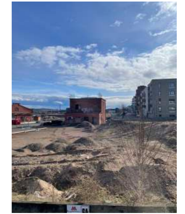
Vy 4. Baksidan av Panncentralen.
