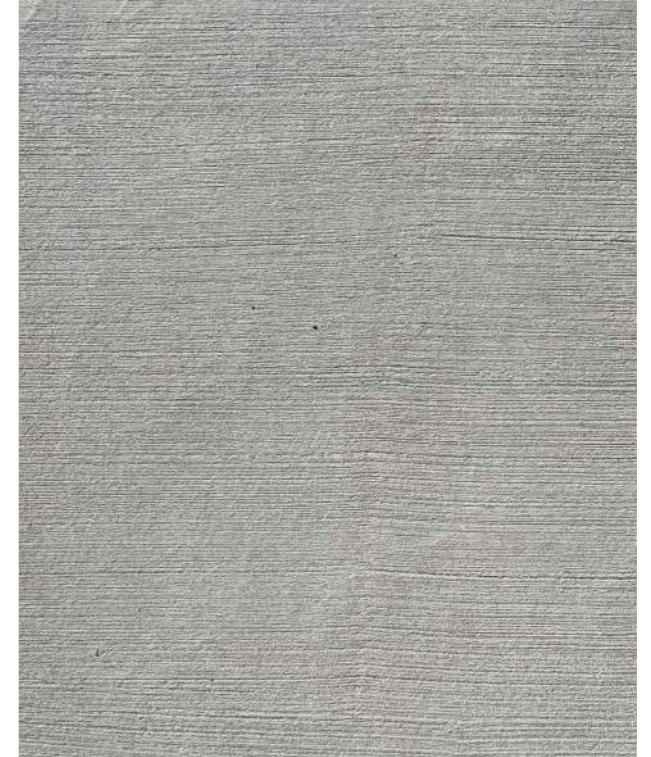
Figur 41/ Munksjökajen består huvudsakligen av platsgjuten betong.
