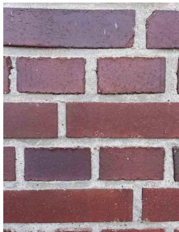
Figur 38/ Det finns olika typer av tegelfasader i området, både hos moderna och historiska byggnader.
