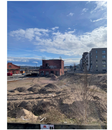
Vy 4. Baksidan av Panncentralen.
