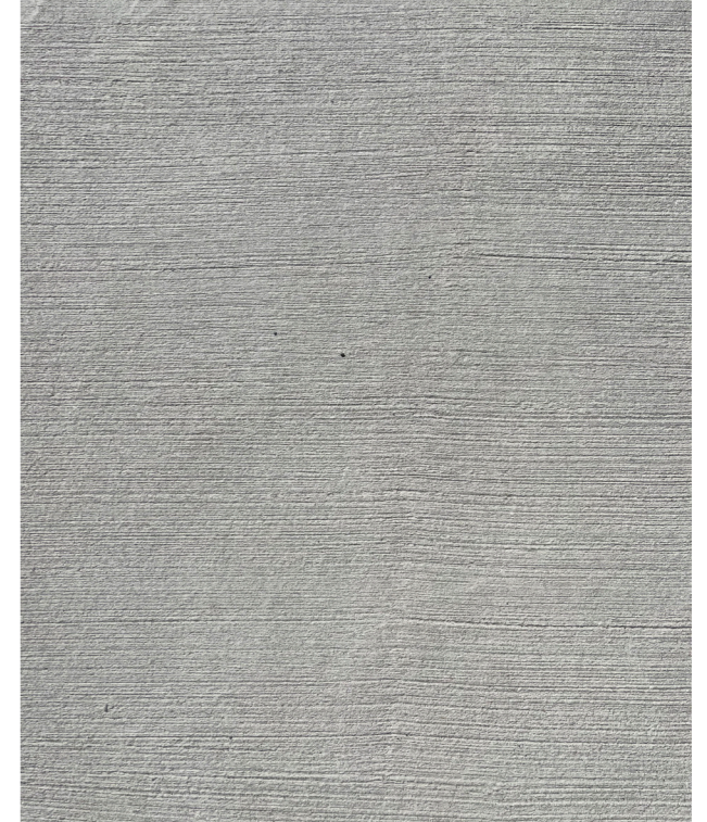
Figur 41/ Munksjökajen består huvudsakligen av platsgjuten betong.
