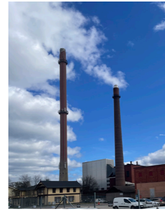
Vy 2. Skorstenar (höger skorsten är den äldre skorstenen)
