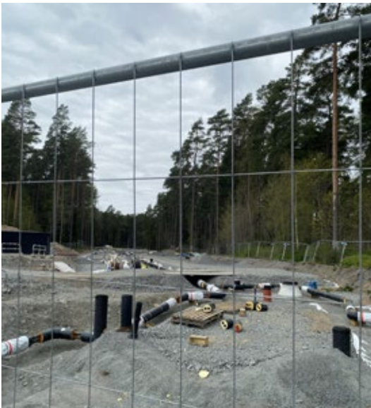
30 / Pågående markarbeten strax söder om kyrkogårdsmuren.
