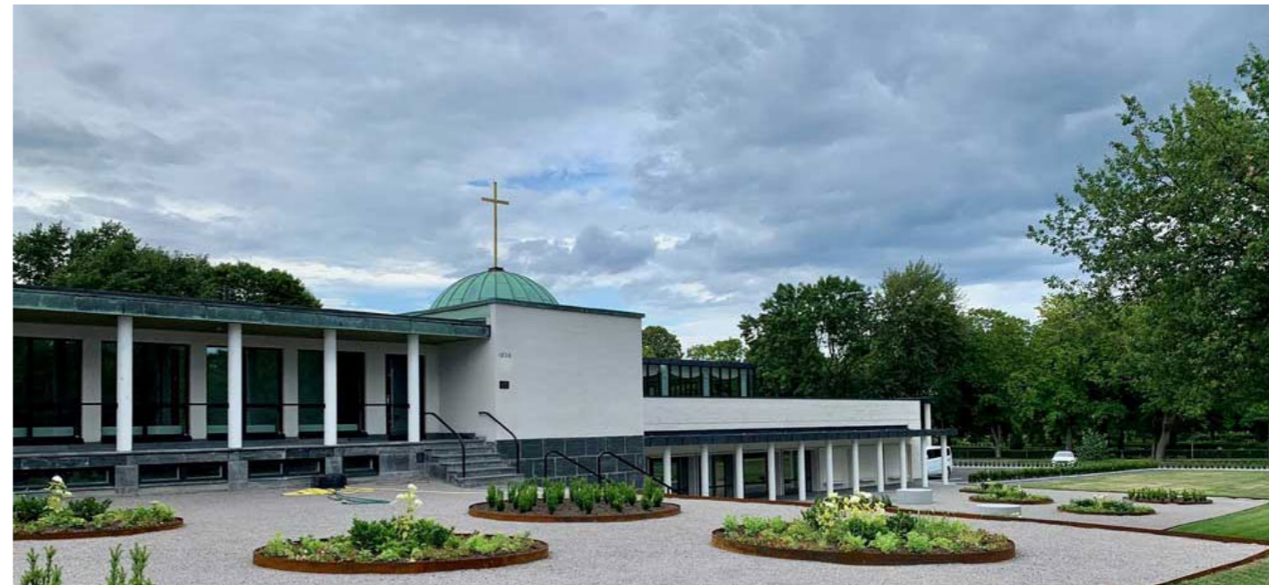
Figur 6. Krematoriet efter utbyggnationen 2022. Till vänster i bild är loggjan som frilades och till höger är utbyggnaden. Foto: Fredriksson arkitektkontor
