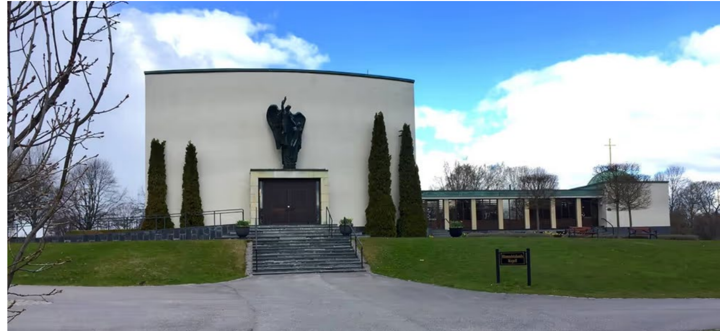
Figur 5. Krematoriet innan renoveringen, 2021-2022. Höger i bild finns loggjan som glasades in 1968 och den luftighet som loggjan hade tidigare, vid invigningen, försvann. Det var ett av de val av von Schmalensee som gav krematoriet en mörkare gestaltning. Foto: Carl Larsson.
