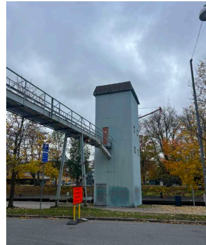
Figur 15. Foto på skeppselevatoren som mäktigt uppstickande torn och volym som sammankopplas med en stålövergång till tegelsilon.
