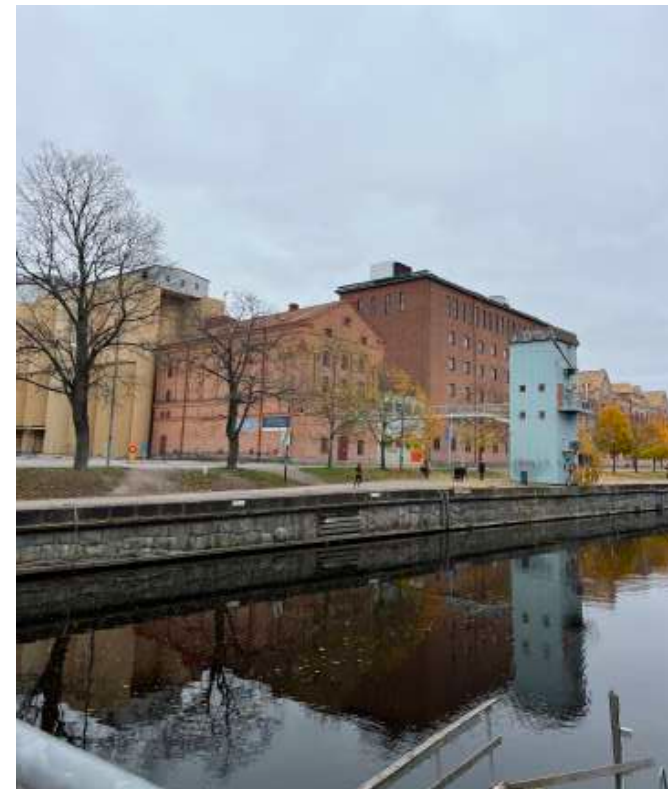
Figur 14. Foto över Ångkvarnskajen från Hamnspången när platsens omgivning och siktlinjer undersöktes.
