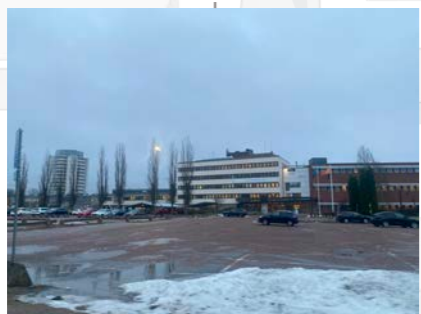
Asfalterad lågpunkt där mer vatten räknas ansamlas efter planens genomförande.
