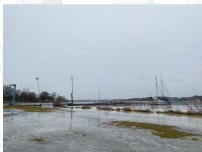
Gräsytan mot vattenbrynet, där det ska byggas sexvåningshus, är helt översvämmad.
