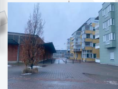
Till vänster rivs den gamla tegelbyggnaden och pelarekarna för att ersättas av ett sexvåningshus.
