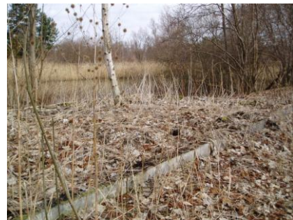
17. Den mystiska husgrunden intill håvningsdammen.
