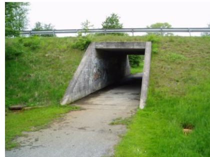
9. Gångtunnel under Lundavägen. Vy mot söder.
