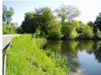
5. Längs Prästbergavägen planeras en utfyllnad för att kunna anlägga ett gångstråk.
