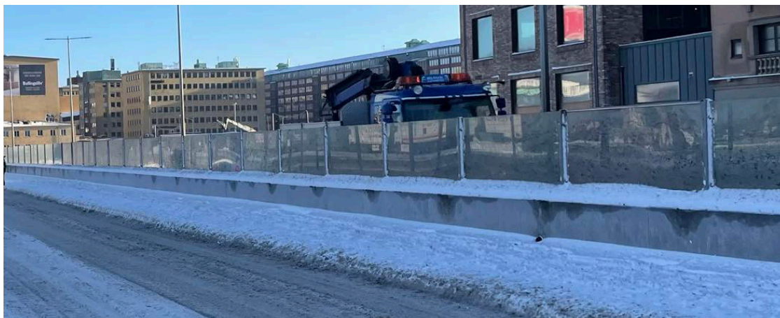
Figur 76: Kombinerat buller- och översvämningsskydd utmed Oscarsleden.
