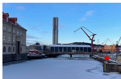
Figur 85: Masthamnsbron över Stora Hamnkanalen avstängd mellan Masthuggskajen och Skeppsbron.
