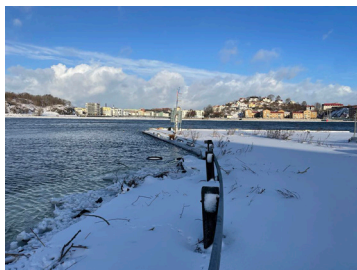
Figur 60: Utblick över Göta älv från Fiskhamnen. Tydligt att vattennivån är relativt nära kajkanten.
