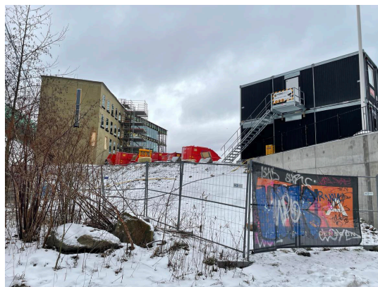
Figur 30: Pågående bebyggelse av kontor i Klippan på hög höjd intill Älvsborgsbron.
