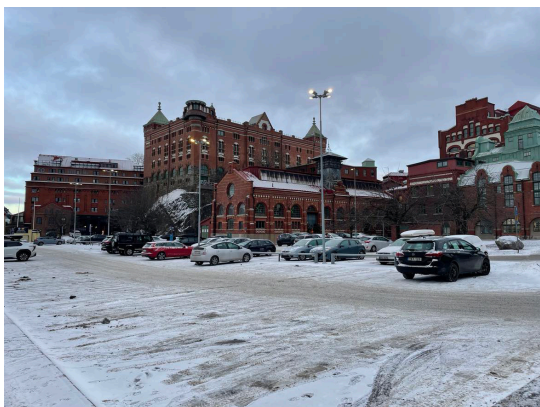
Figur 29: Kulturhistoriskt värdefulla industribyggnader i Klippan i rött tegel.
