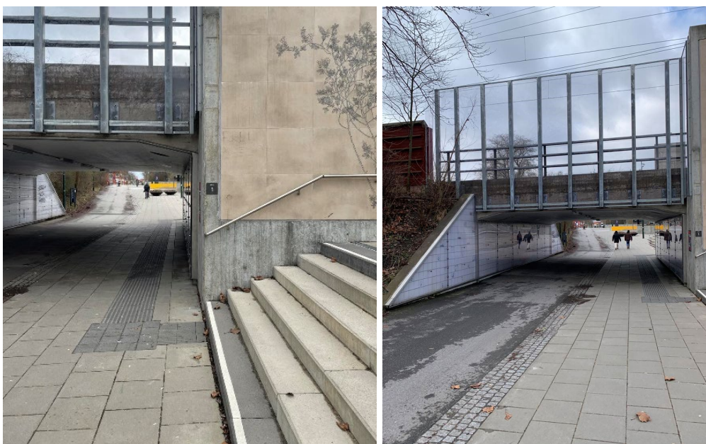
Bild 33a-b. Visar slänten på andra sidan tunneln samt de taktila plattorna som leder upp för trapporna.
