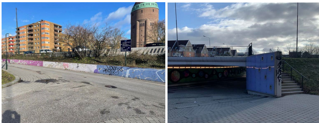
Bild 29 och 30. Vänster bild visar stödmuren som går längst vägen samt slänten ner mot tunneln. Höger bild visar trappstegen mot höger och slänten med trappsteg mot tunneln.
