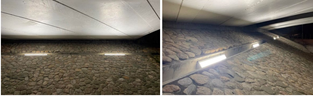
Bild 45a-b. Visar belysningsarmaturen som lyser mot det vita taket.
