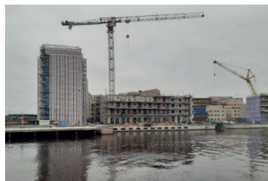
Figur 38. Under byggnationen av området var Kolkajen helt avspärrat vilket försvårade platsbesök.
