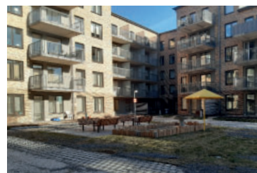
Figur 7. Igelsta Strandentré och dess innergård.
