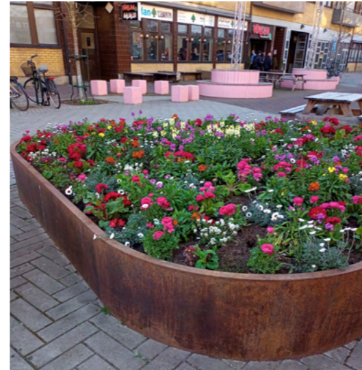
Figur 40. Upphöjd plantering i cortenstål, gör att man kommer närmare växterna och materialvalet ger ett modernt uttryck
