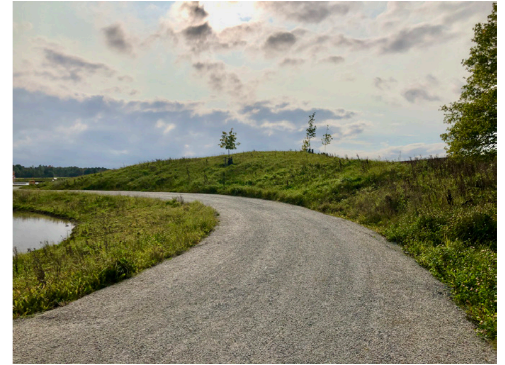
Figur 17. Schaktmassorna från våtmarken har använts för att skapa kullar som ramar in platsen.
