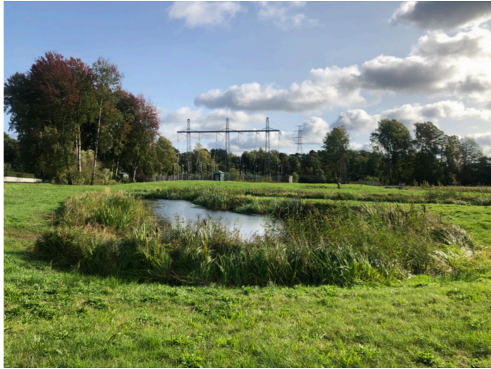
Figur 21. Den täta växtligheten i dagvattendammens strandkant utgör en barriär mot vattnet som kan vara fördelaktig av säkerhetsskäl vid dammens djupare delar.
