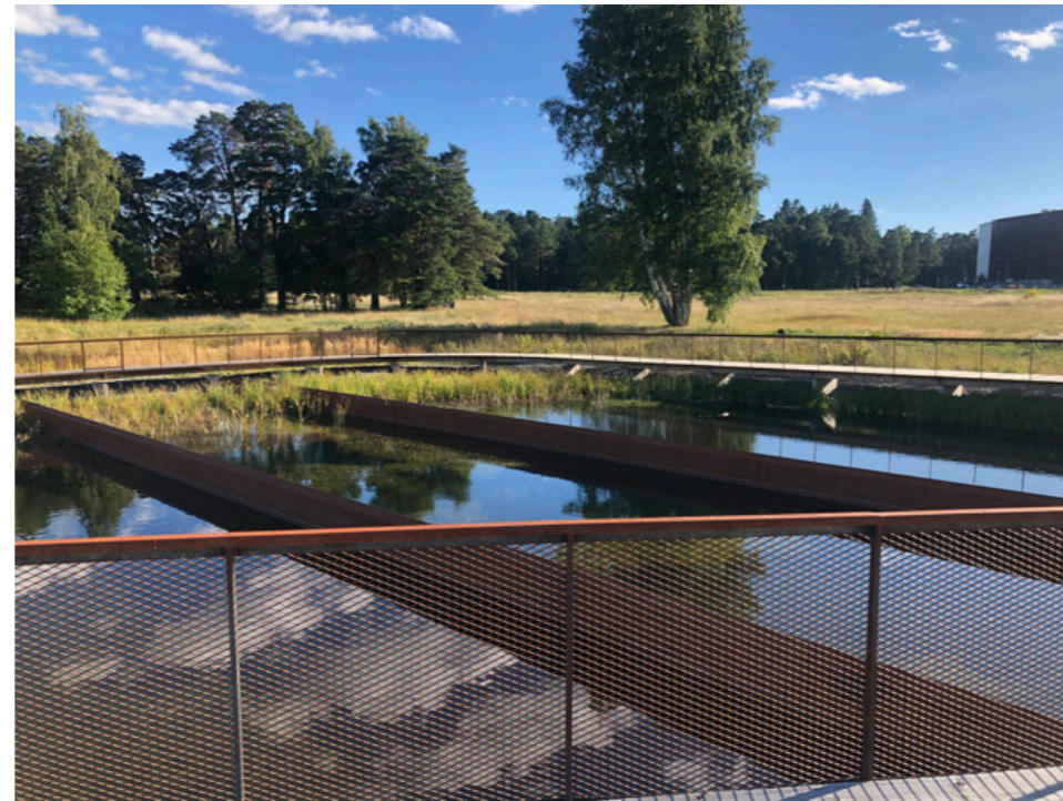
Figur 28. Väggarna som är utformade för att styra vattnet bidrar till en anlagd karaktär jämfört med vallar, som exempelvis i Johannisbergs våtmarkspark.
