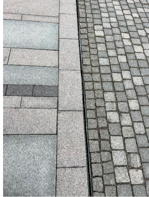
Figur 7. Öppen dagvattenavledning via linjeavvattning, Växjö
