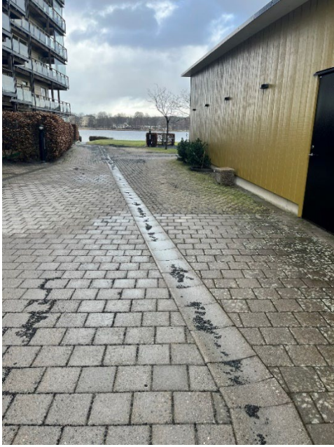
Figur 8. Öppen dagvattenavledning via dagvattenränna, Växjö
