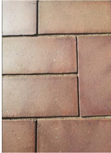
Figur 36. Brunt höganäsklinker, ett material som använts både på altanen, den upphöjda rabatten och muren på gårdsplanen. (Foto: Hanna Nilsgård, november 2023).
