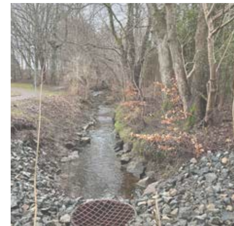
Figur: 27. Ca 2m kanthöjd. Krossmaterial som erosionskydd samt stabilisering av kulvertöppning. Foto av författaren
