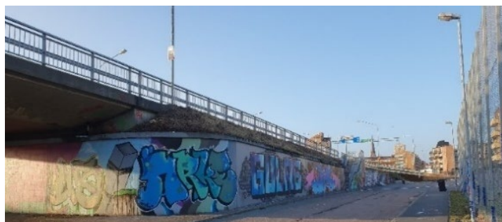
Figur 14. Bilden visar den aktuella platsen söderifrån. Södergatsviadukten syns till höger. Till vänster syns gunnebostängslet.
